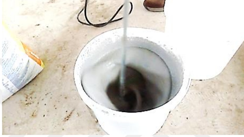
Şekil 5.1. Grout harçlarının hazırlanması
