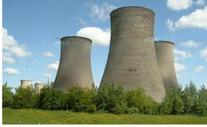
Şekil 3.5. Doğal akımlı su soğutma kuleleri [18]
