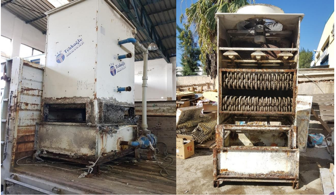
Şekil 3.21. Bakım öncesi soğutma kuleleri
