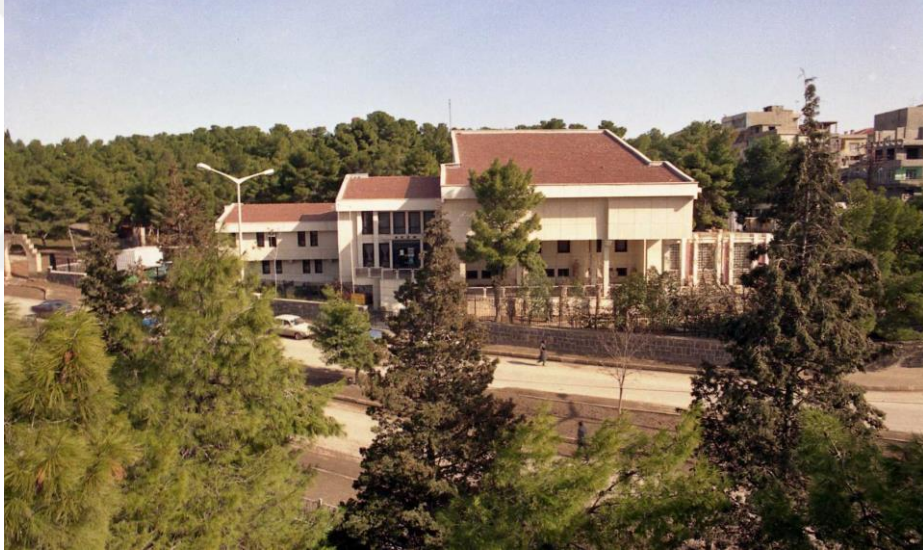
Fotoğraf:86 Şanlıurfa Müzesi Eski Hizmet Binası
