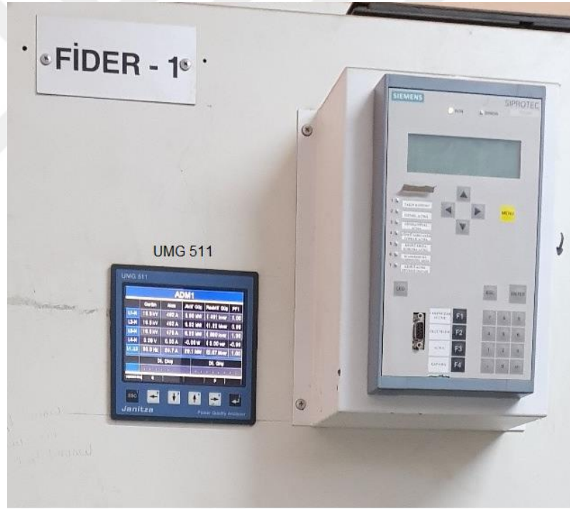
Şekil 4.3. YDM 13 dağıtım merkezinde ölçüm cihazı görünümü
