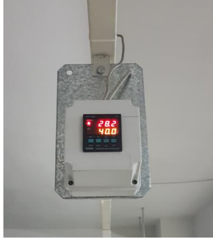
Şekil 3.32. Enda ET4420 sıcaklık kontrol cihazı montajı
