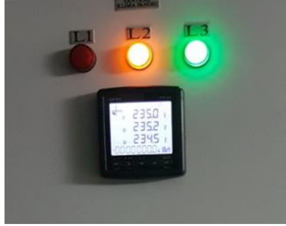
Şekil 3.33. Entes MPR-45S montajı
