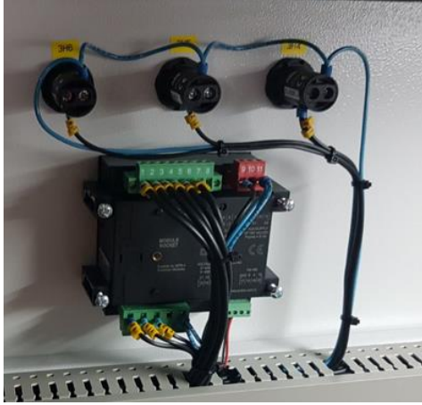
Şekil 3.33. Entes MPR-45S montajı
