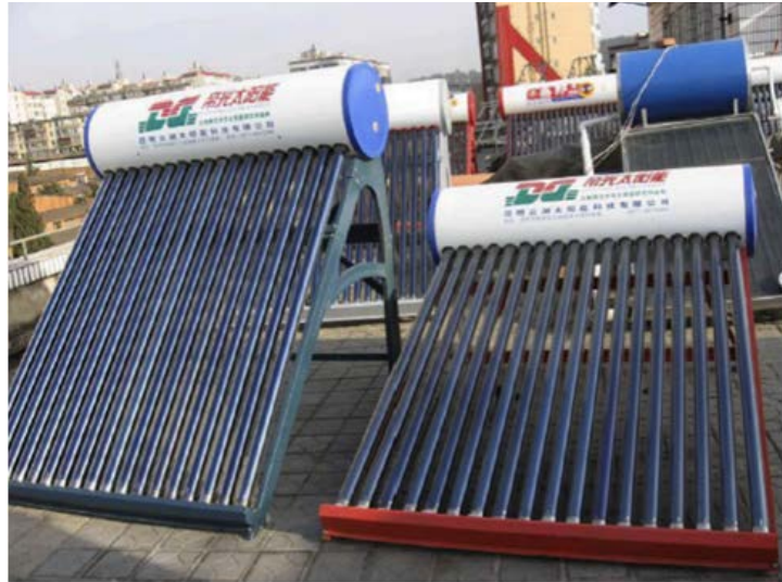
Şekil 2.4: Bir Ucu Açık Vakum Tüplü Güneş Kollektörü [62]
