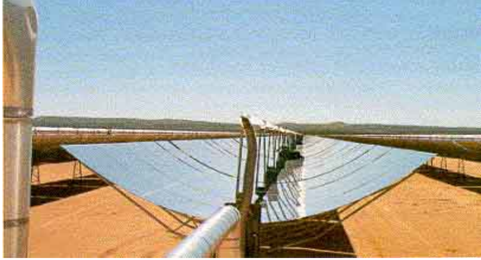
Şekil 2.8. Parabolik Oluklu Güneş Kolektörü
