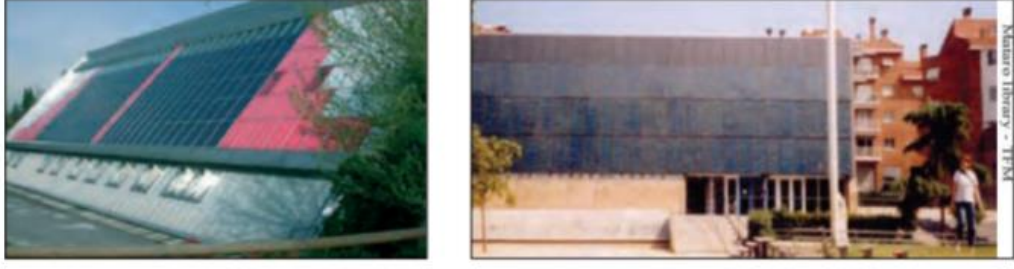
Şekil 3.6. Havalandırılmalı PV Kolektörün Uygulaması [6,47]
