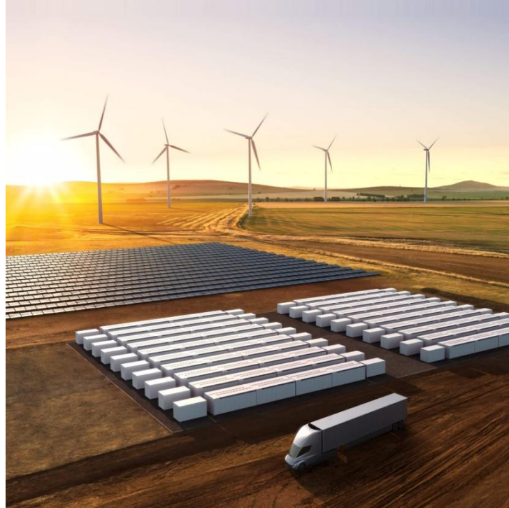
Şekil 2.6. Tesla Megapack enerji depolama tesisi [48]
