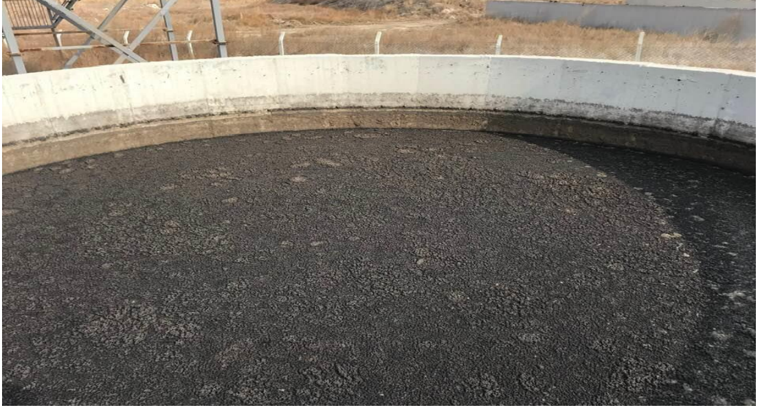
Şekil 2.3. Bulamaç kıvamına gelmiş tank içi görüntü
