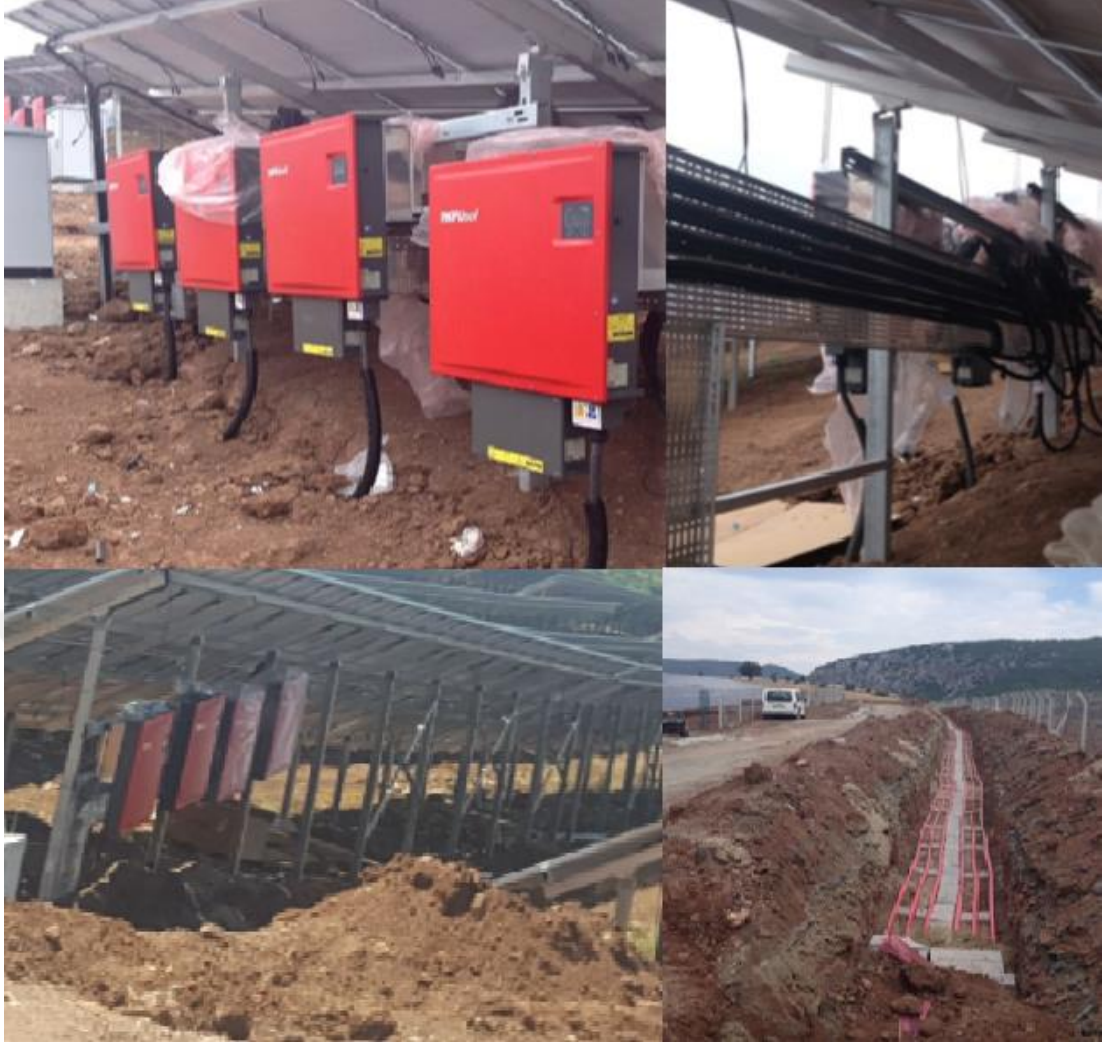
Şekil 2.11: Örnek Güneş Santrali İnşaatı
