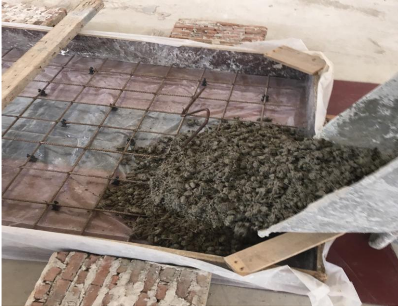
Şekil 3.9 Döşeme betonu karışımının kalıba aktarılması
