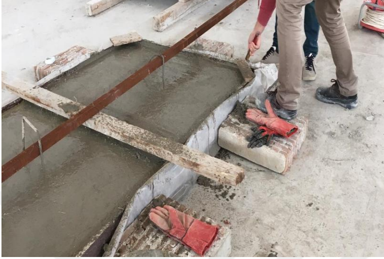
Şekil 3.12 Döşeme betonu kalıbının tokmaklanması
