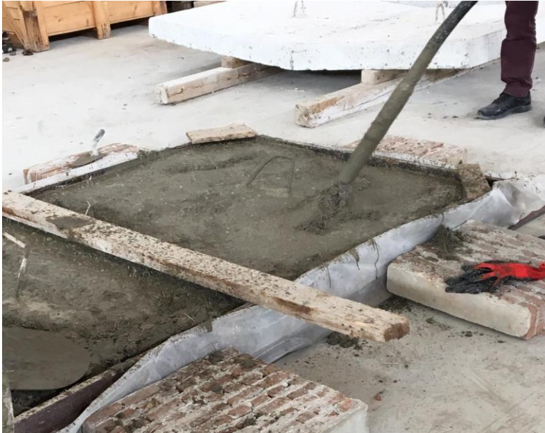
Şekil 3.11 Beton vibratörü yardımıyla betonun yerleştirilmesi
