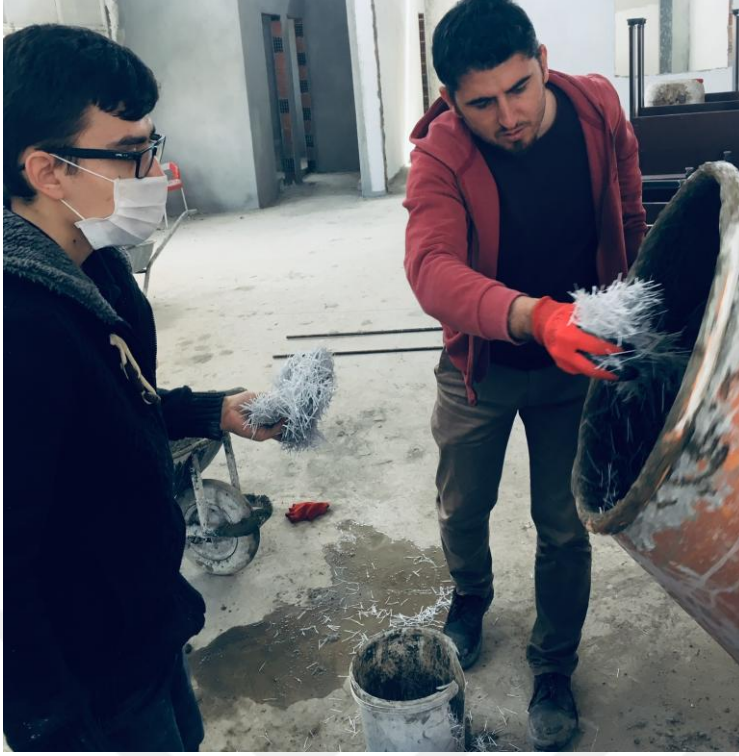
Şekil 3.8 Polipropilen liflerin beton karışımına eklenmesi
