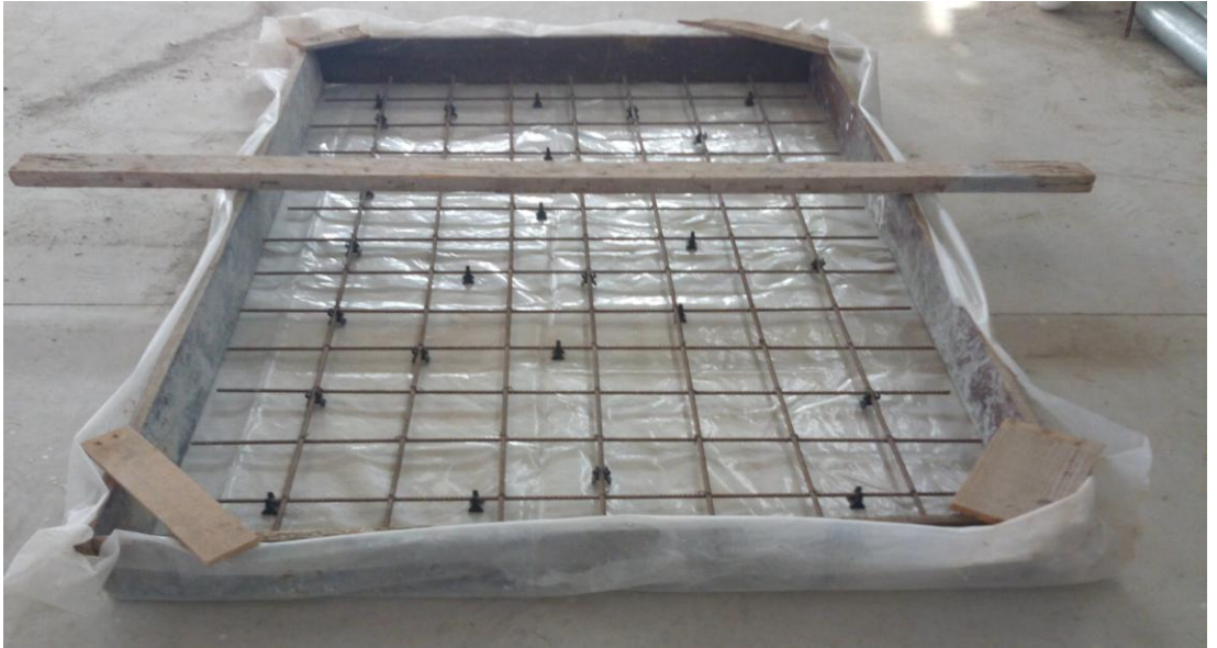
Şekil 3.5 Kalıba membran malzemenin yerleştirilmesi
