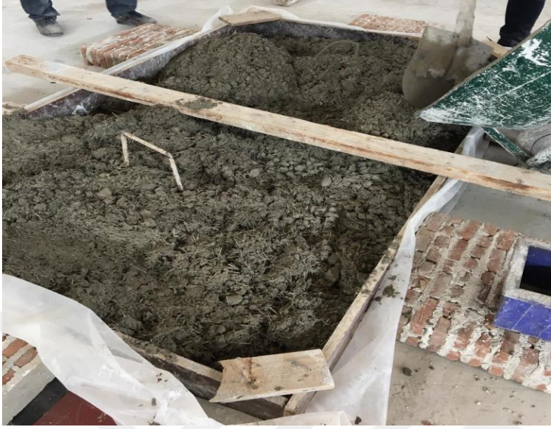
Şekil 3.10 Döşeme betonunun kalıba aktarılması
