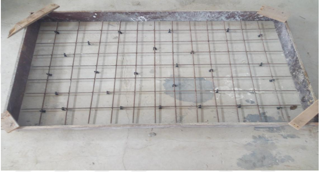
Şekil 3.4 Kalıp montajı
