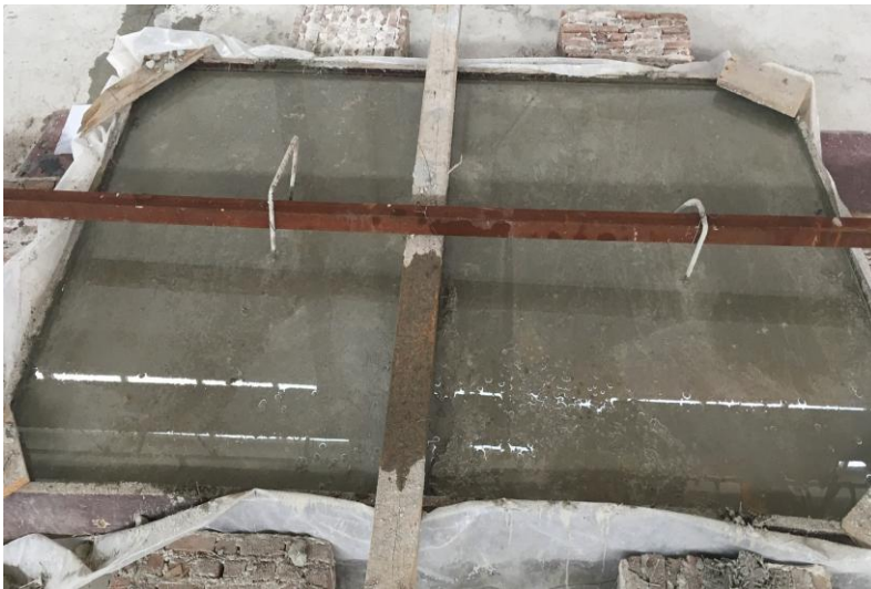
Şekil 3.13 Döşemenin kürlenmesi
