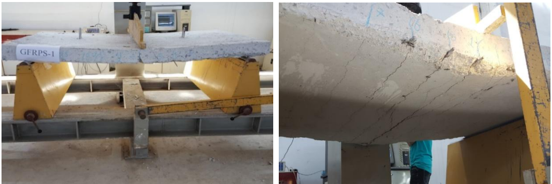
a) GFRPS-1 için hasar durumu
