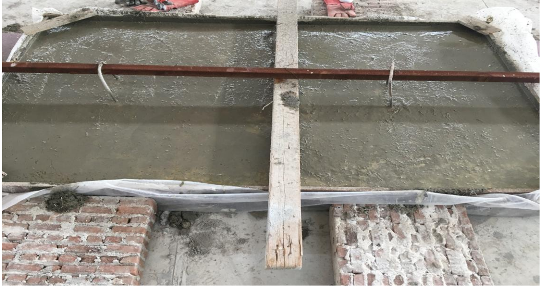
Şekil 3.2 Üretilen GFRPS-F döşemesi
