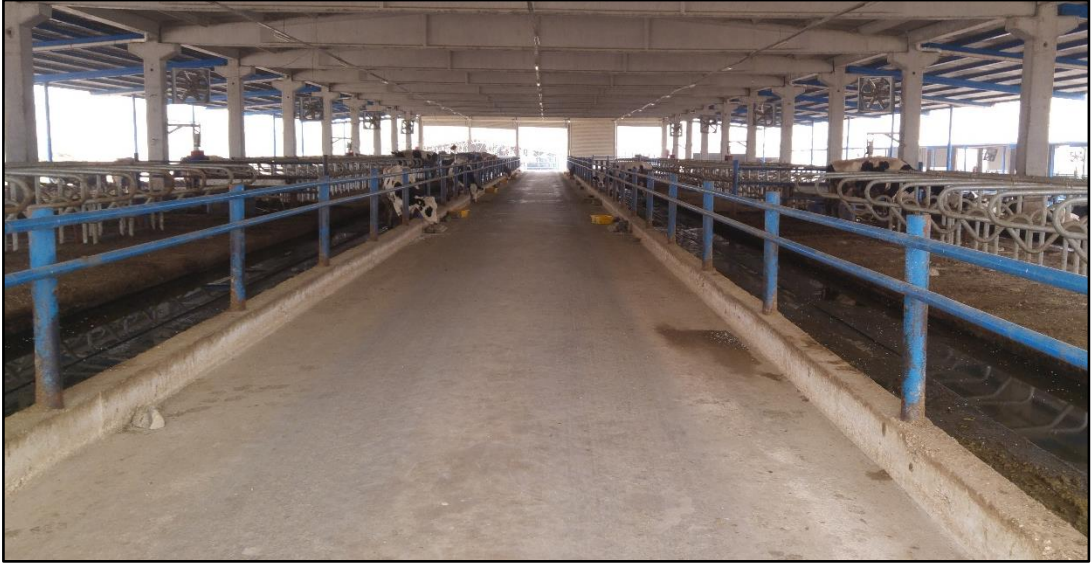
řekil 10. Diyarbakır ilindeki süt sığırçılıęı iřletmesi.
