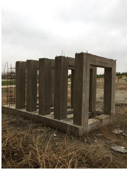
Şekil 3.9. Betonarme çerçeve sistem.
