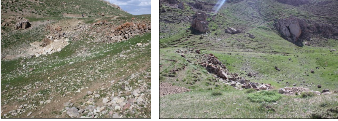
Şekil 0.21. Rusa GB barajı memba ve mansaba ait görünümler.
