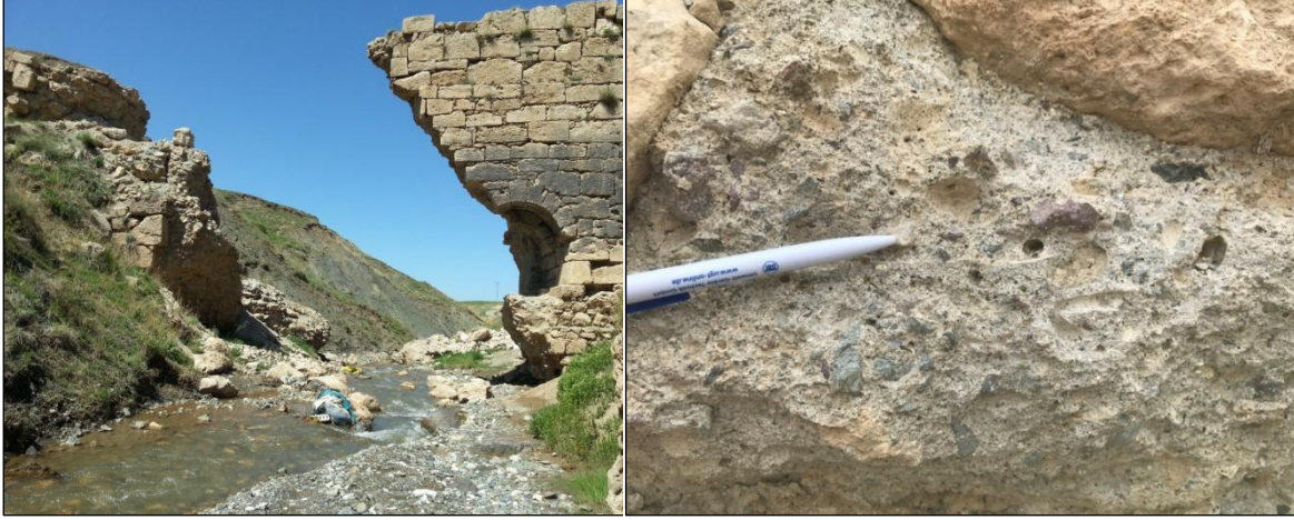
Şekil 0.18. Faruk Bendi duvar yapısı ve bağlayıcı malzemesi.
