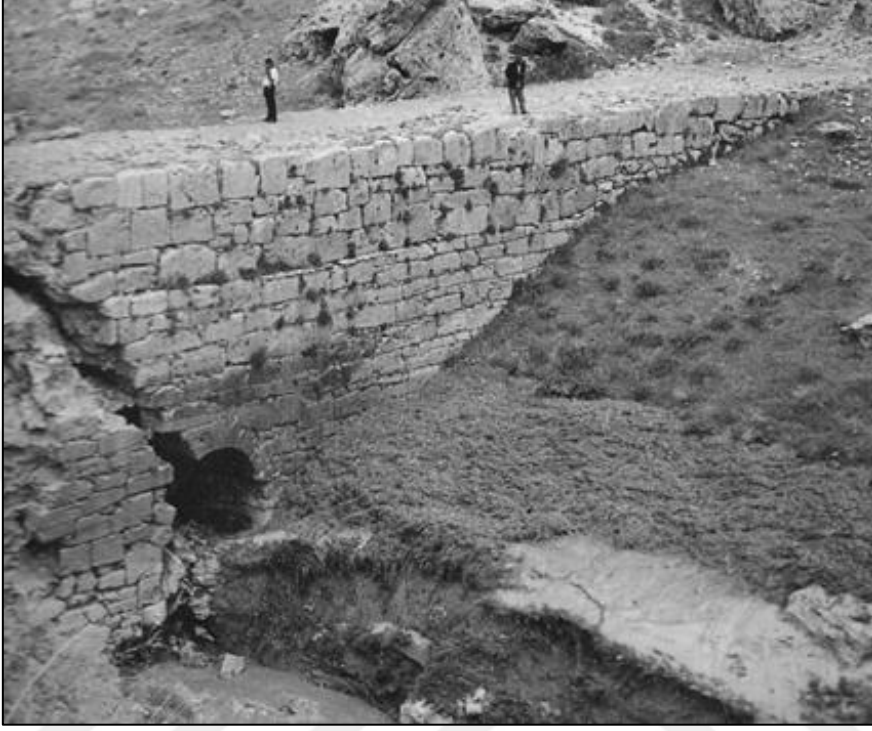
Şekil 0.24. Faruk Bendi'nin yıkılmadan önce membadan görünüşü (Bildirici, 2009'dan alınmıştır).
