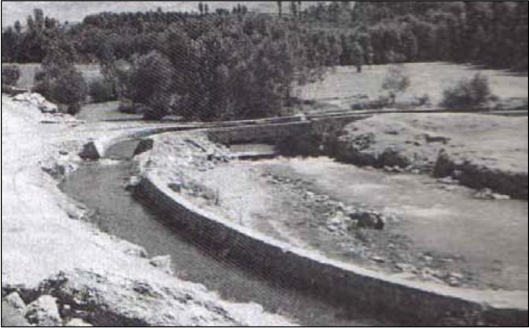
Şekil 0.13. Şamran Kanalı'nın Engil çayını beton köprü (aşirtma kemeri) ile geçişi (Bildirci, 2009'dan alınmıştır).
