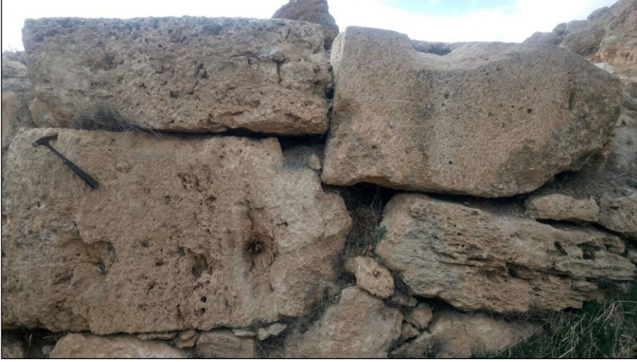
Şekil 0.15. Faruk bendi traverten yapı malzemesinin akış yukarı duvarından görünümü.
