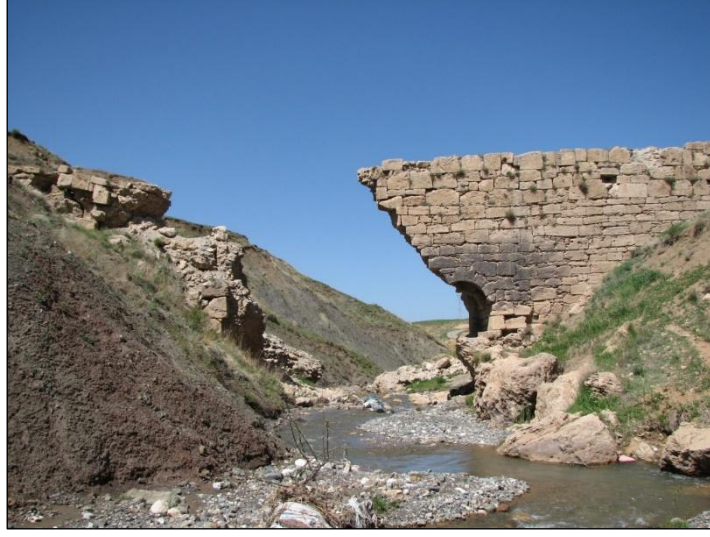
Şekil 0.29. Faruk bendinin günümüzdeki kısmen yıkık halinin mabadan görünümü.
