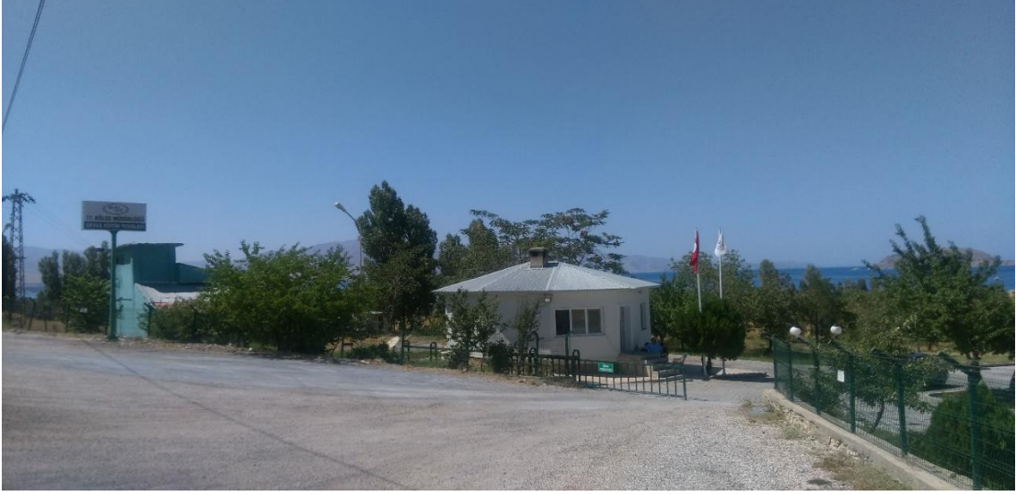
Şekil 4.29. Gevaş DSİ Eğitim Tesisi.
