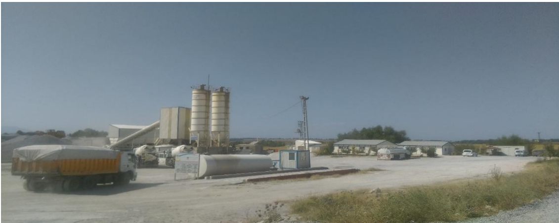
Şekil 4.26. Kandaşoğlu beton üretim şantiyesi.
