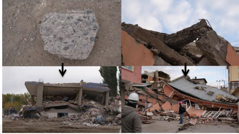
Şekil 3.4. Van depreminde yıkılmış beton dayanımı kötü olan yapılar
