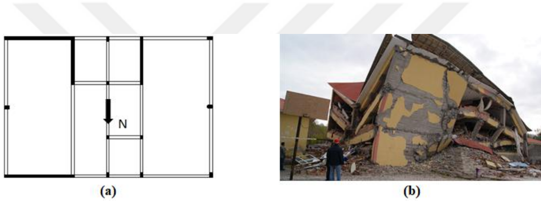
Şekil 3.15. a. Gedikbulak Köyü'ndeki okulun yapısal planı, b. okulun depremden sonraki durumu (Erdil ve Ceylan, 2018)
