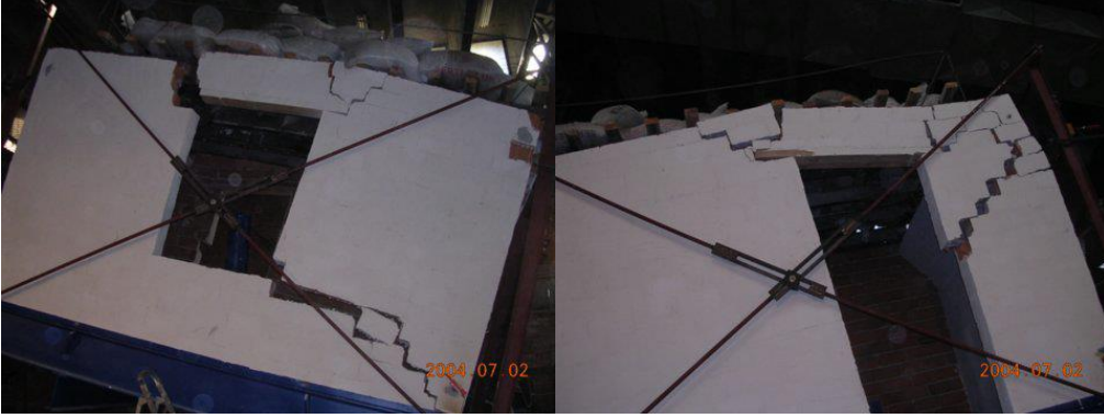
Şekil 2.6. Ana duvarlar üzerinde oluşan çapraz çatlakların dağılımı (Türer ve ark., 2013).
