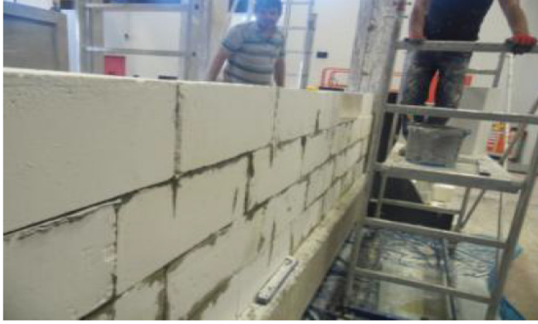
Şekil 3.25. Ses yalıtım testi için duvar örülmesi.
