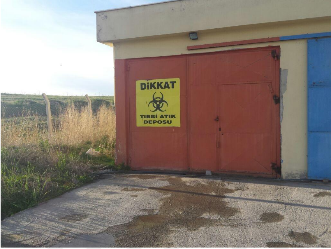
Şekil 1.7. Tıbbi atık geçici deposu örneği.
