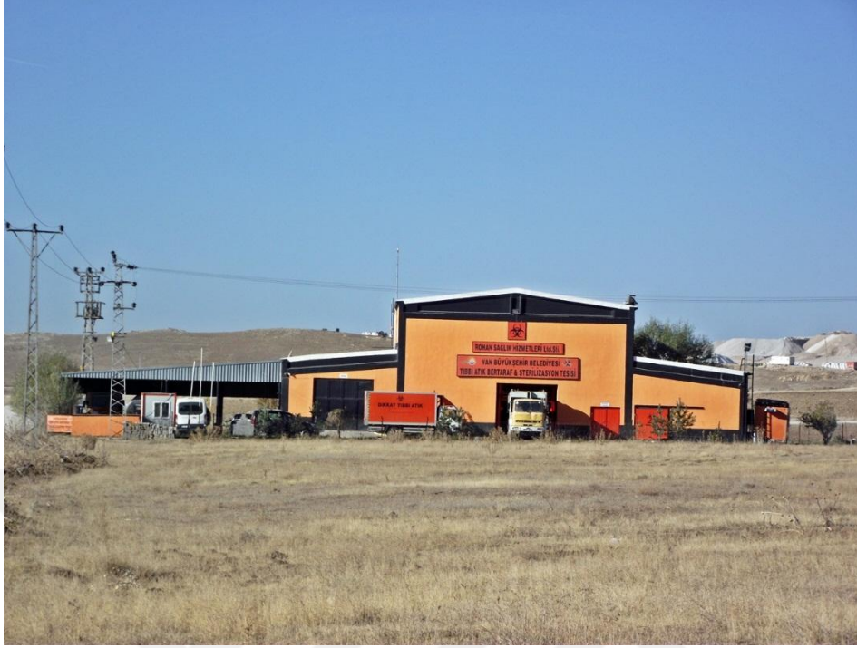
Şekil 3.2. Van tıbbi atık sterilizasyon tesisi, 2018.
