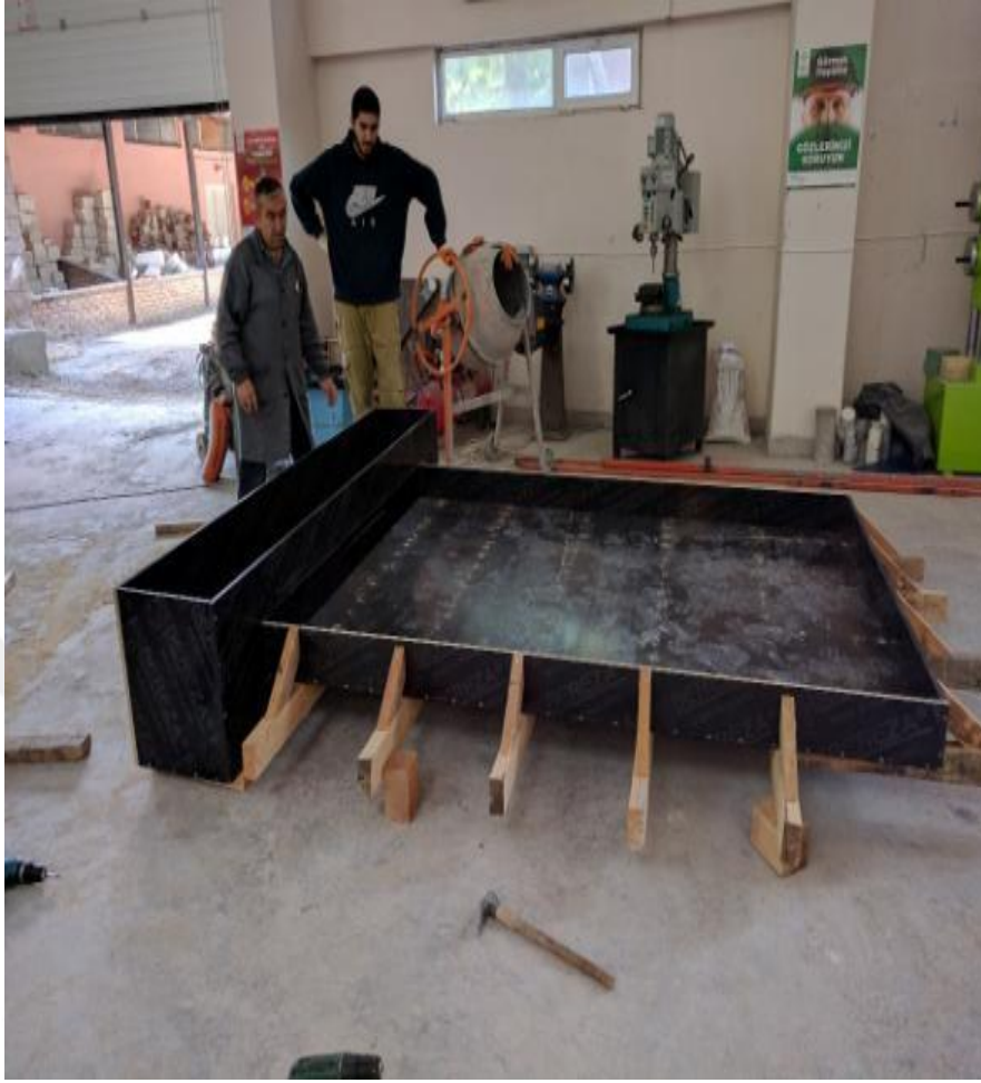
Şekil 3.10. Temel ve perde birleşimi kalıp imalatı.
