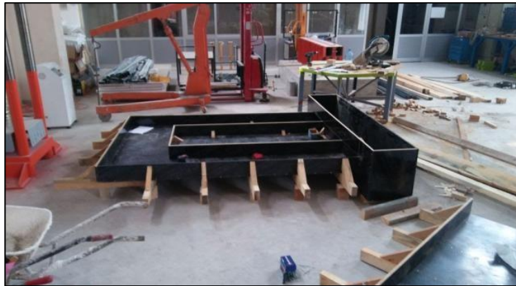
Şekil 3.9. Kapı açıklığı kalıp imalatı.
