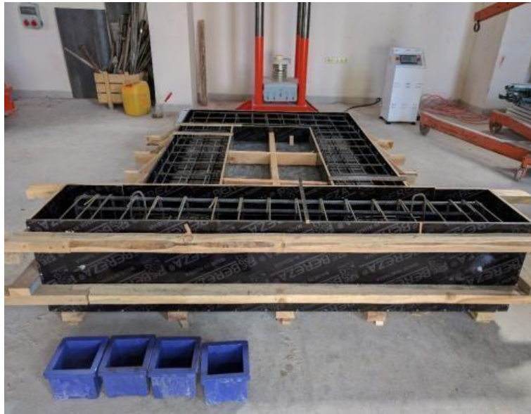
Şekil 3.18. Donatı imalatı tamamlanmış kapı açıklığı.
