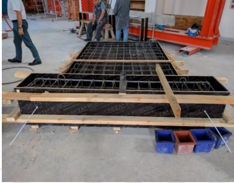
Şekil 3.19. Donatı imalatı tamamlanmış tam dolu perde.
