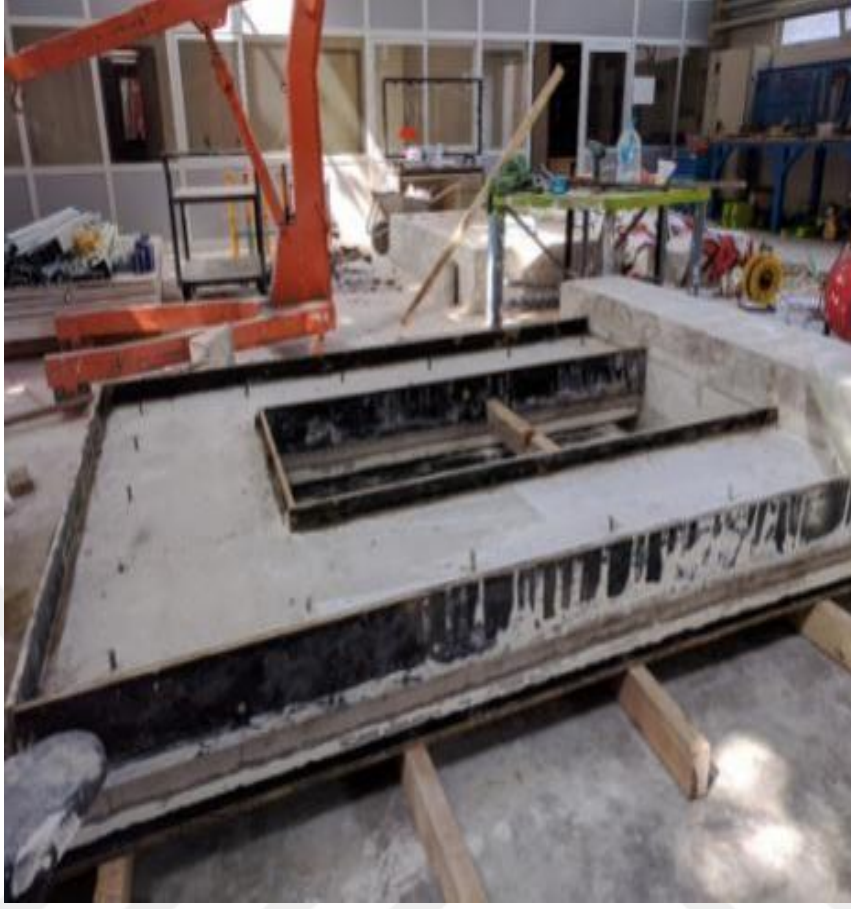
Şekil 3.27. Çimento bağlayıcılı yalıtım malzemesinin kalıbı.
