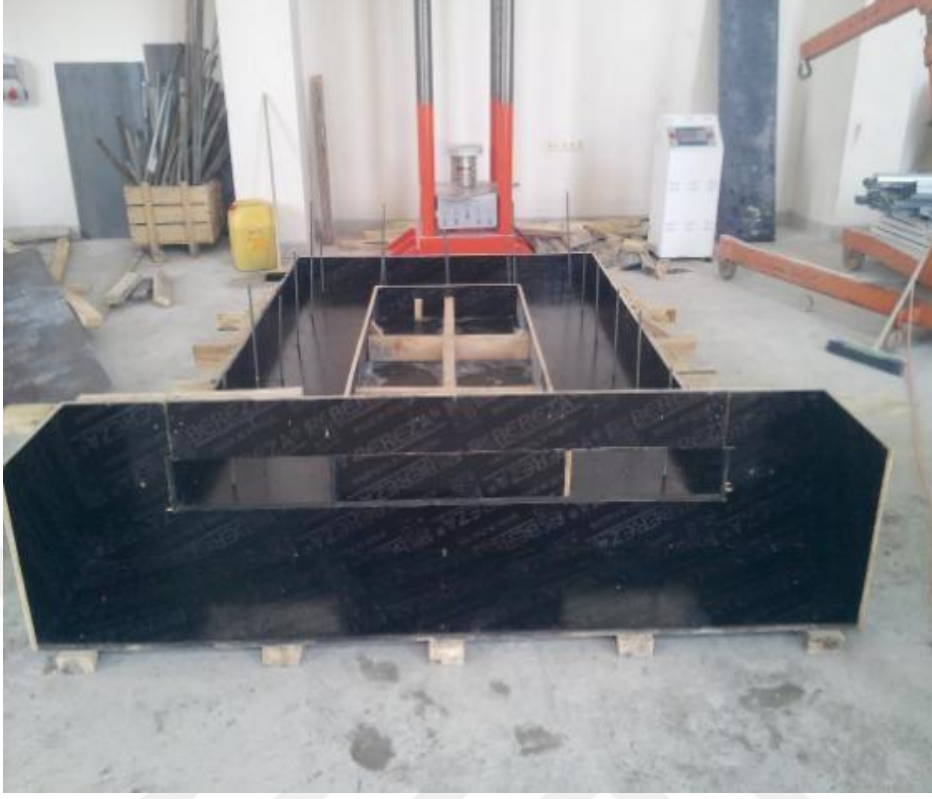
Şekil 3.13. Ankrajlı kapı açıklığı kalıp imalatı.
