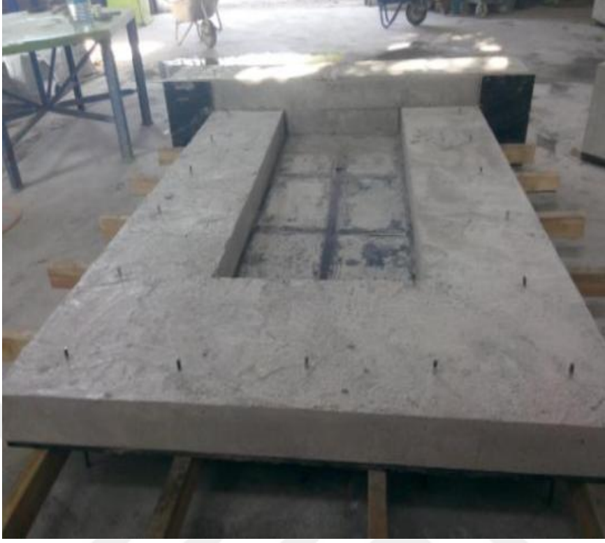
Şekil 3.26 Ankraj donatıları kesilmiş betonarme elemanı.
