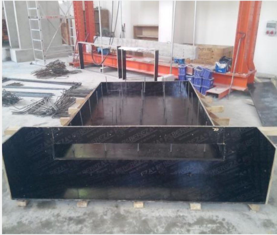
Şekil 3.14. Ankrajlı tam dolu perde kalıp imalatı.
