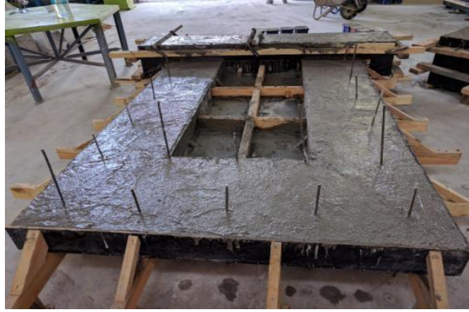
Şekil 3.24. Ankrajlı kapı açıklığı beton tesviyesi.
