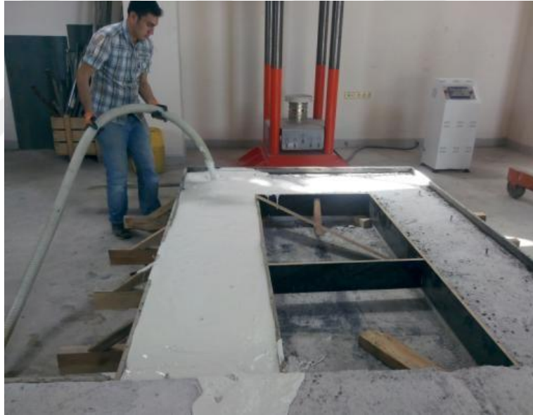
Şekil 3.31. Çimento bağlayıcılı yalıtım malzemesinin kalıba dökümü.
