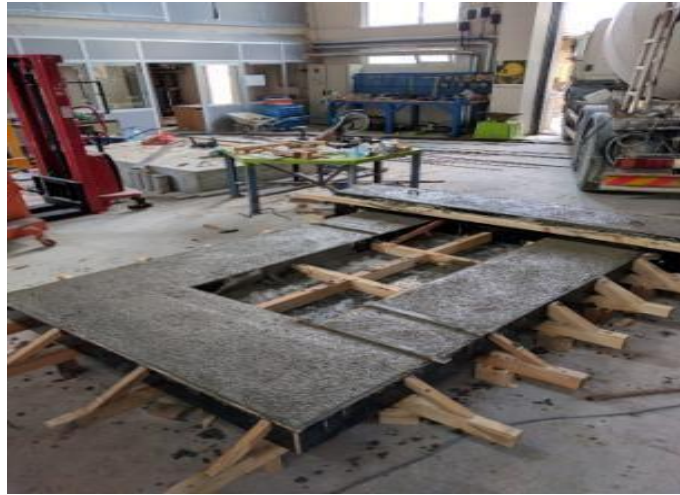
Şekil 3.23. Kapı açıklığı beton tesviyesi.
