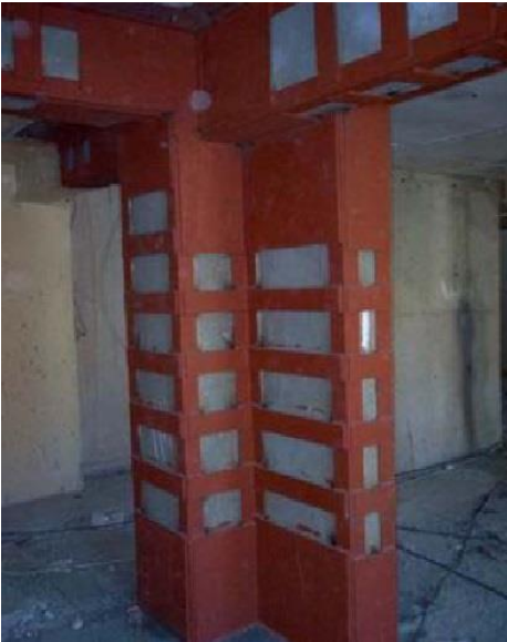
Şekil 2.16. Çelik manto ile güçlendirme (Kuzu, 2009).
