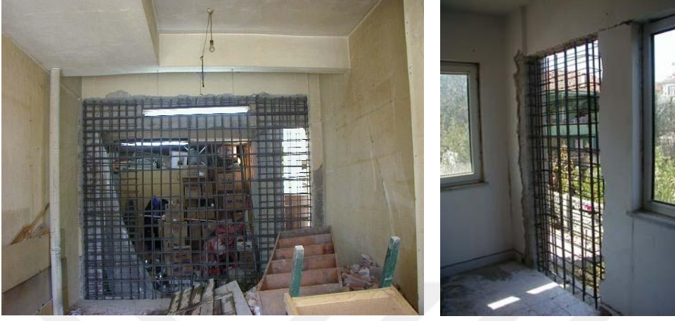
Şekil 2.22. Yerinde dökme perde duvar güçlendirme donatılandırma (Altın, 2008).
