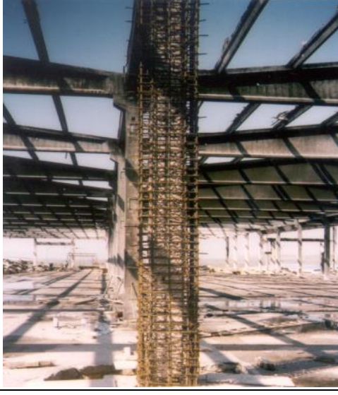
Şekil 2.15. Betonarme manto ile güçlendirme (Yazıcı, 2018).
