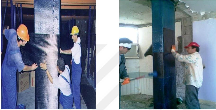
Şekil 2.17. Lifli polimer sargılaması ile güçlendirme çalışmaları (Anonim, 2018).
