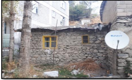
a) Güneybatı cephesinden görünüm
