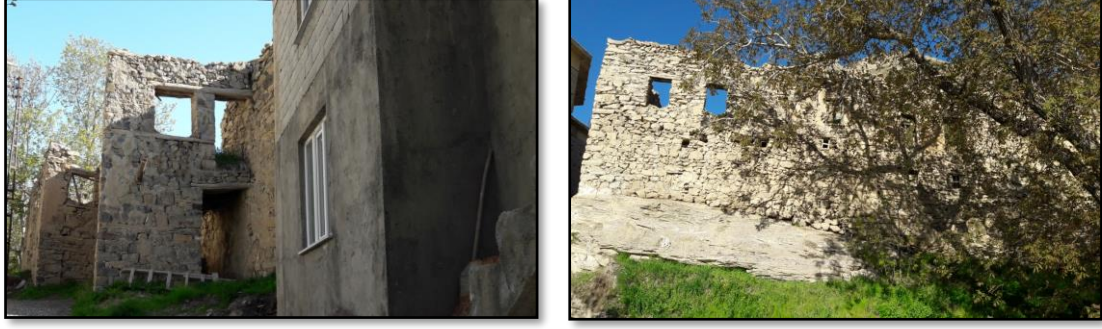
a) Güney cephesinden görünümü b) Batı cephesinden görünümü Şekil 4.97. Envanter 16 numaralı eve ait fotoğraflar.
