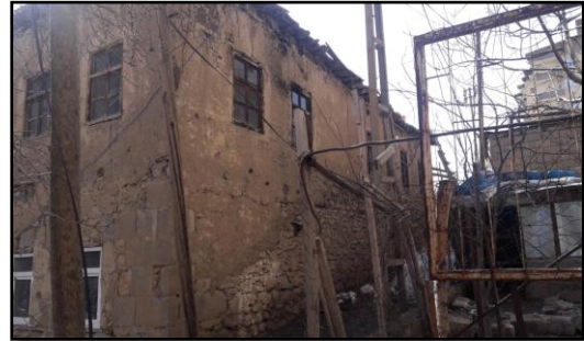
b) Kuzeydoğu cephesinden görünüm
