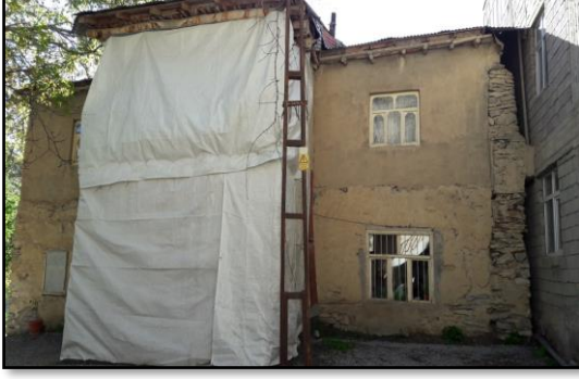
a) Doğu cephesinden görünümü
