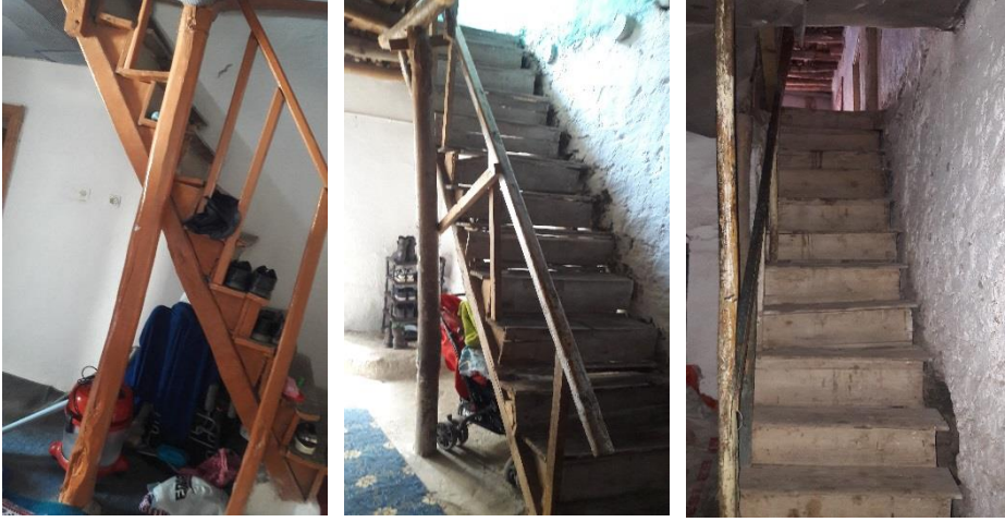
Şekil 5.11. Alt kat sofasının üst kat sofasına bağlayan yapı elemanı merdivenler.
