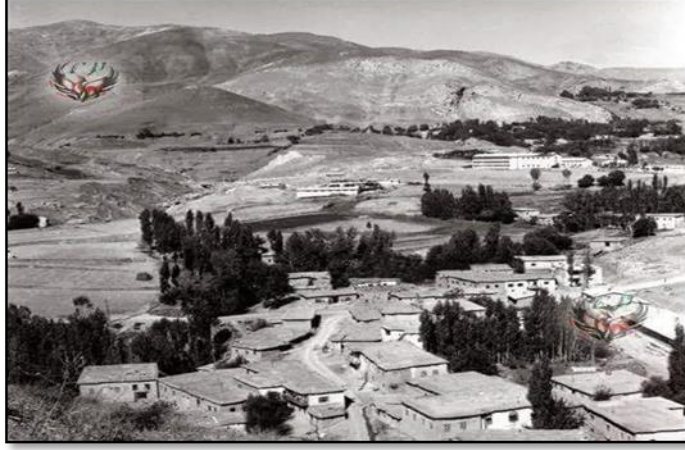
Şekil 4.14.1960'lı yıllarda Hakkâri yerel evleri (Anonim, 2018e).
