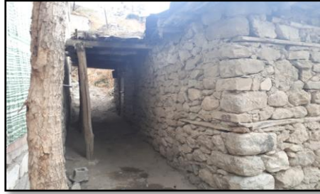
b) Giriş cephesinden görünüm
