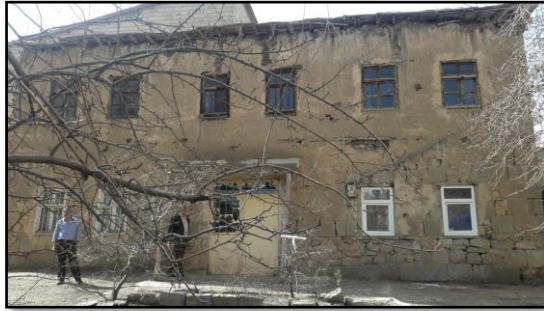
a) Güneydoğu cephesinden görünüm
