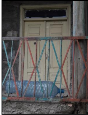
a) Balkon giriş kapısı
