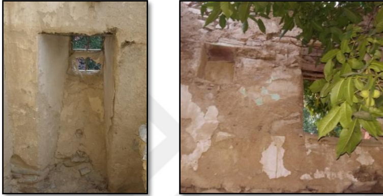
a) Alt kat penceresi b) Üst katta yer alan niş ve kapı boşluğu Şekil 4.98. Envanter 16 numaralı eve ait iç mekân fotoğrafları.
