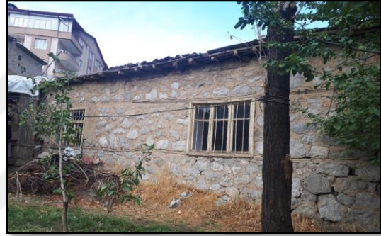
b) Güneybatı cephesinden görünümü
