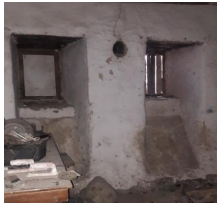
b) Alt kat pencerelerinin içten görünüm
