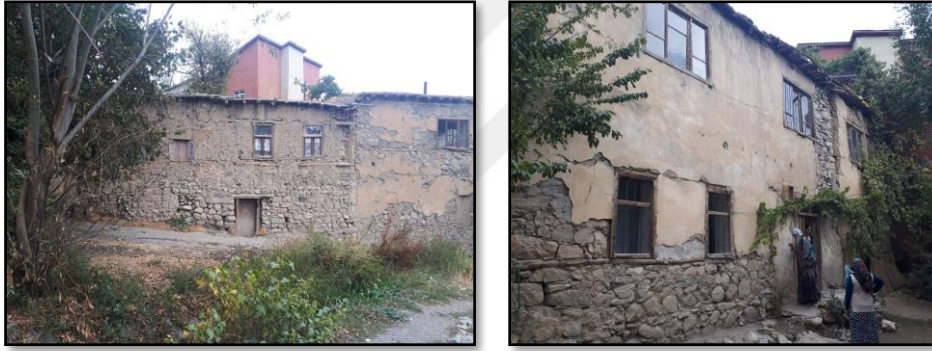
a) Güneybatı cephesinden görünüm b) Güneydoğu cephesinden görünüm
