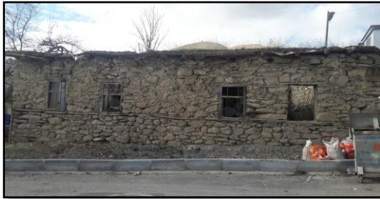
a) Doğu cephesinden görünümü
