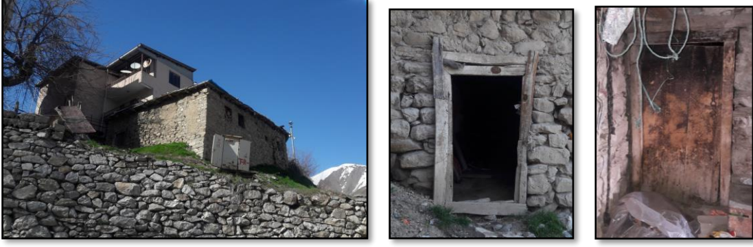
a) Kuzeydoğu cephesinden görünümü
