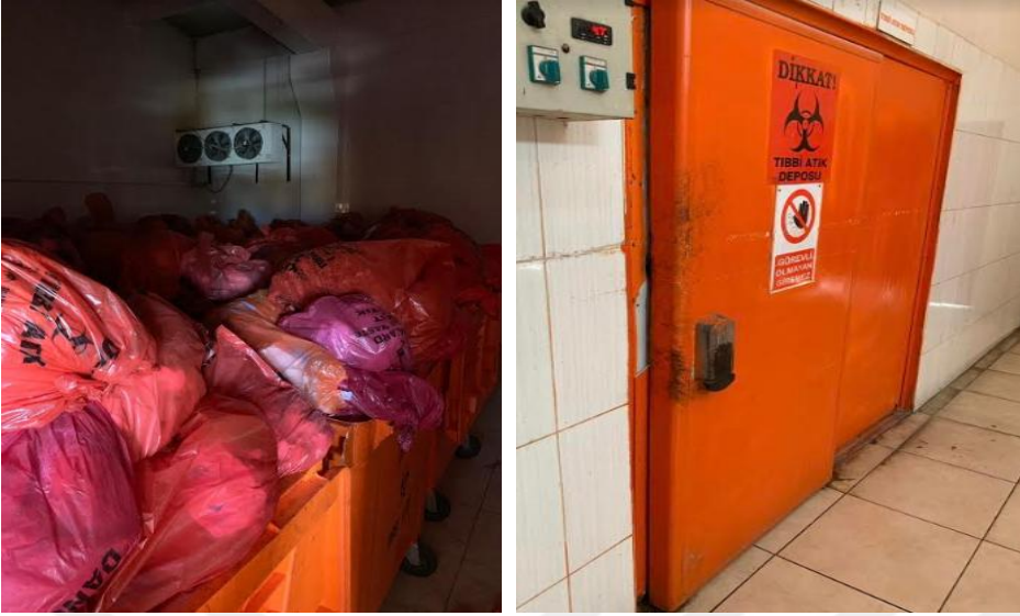
Şekil 3. 1. Geçici atık deposu.
