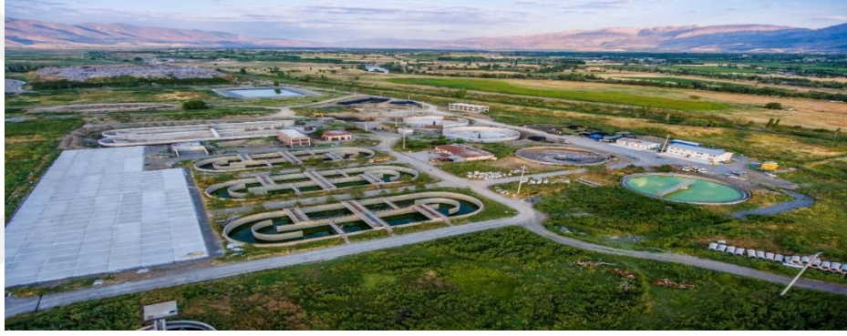
Şekil 6. Su Arıtma Havuzları
