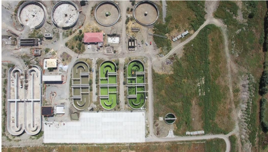
Şekil 5. Atık Su Arıtma Tesisi Havuzları
