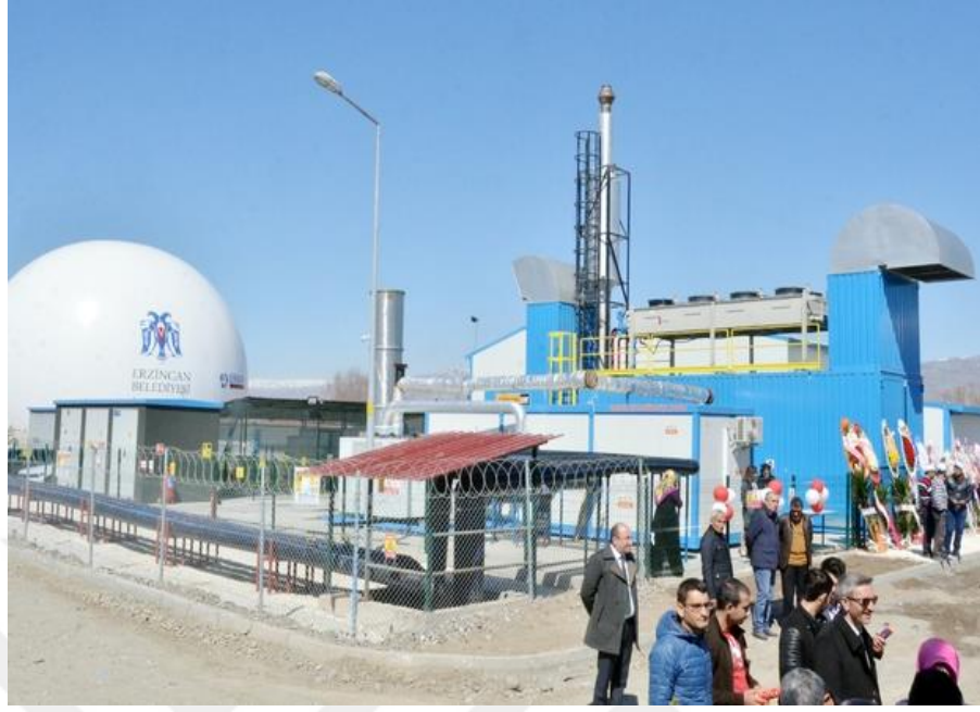
Şekil 7. Erzincan Katı Atık Tesisi
