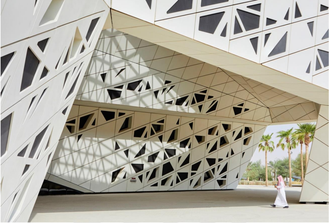
Şekil 1.28. KAPSARC Cephe Kurgusu (Anonim, 2018g).
