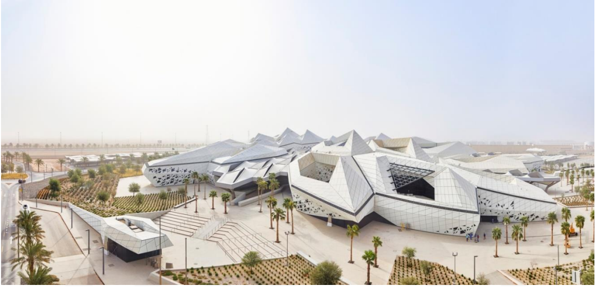
Şekil 1.23. KAPSARC Üstten Görünüşü (Anonim, 2018g).
