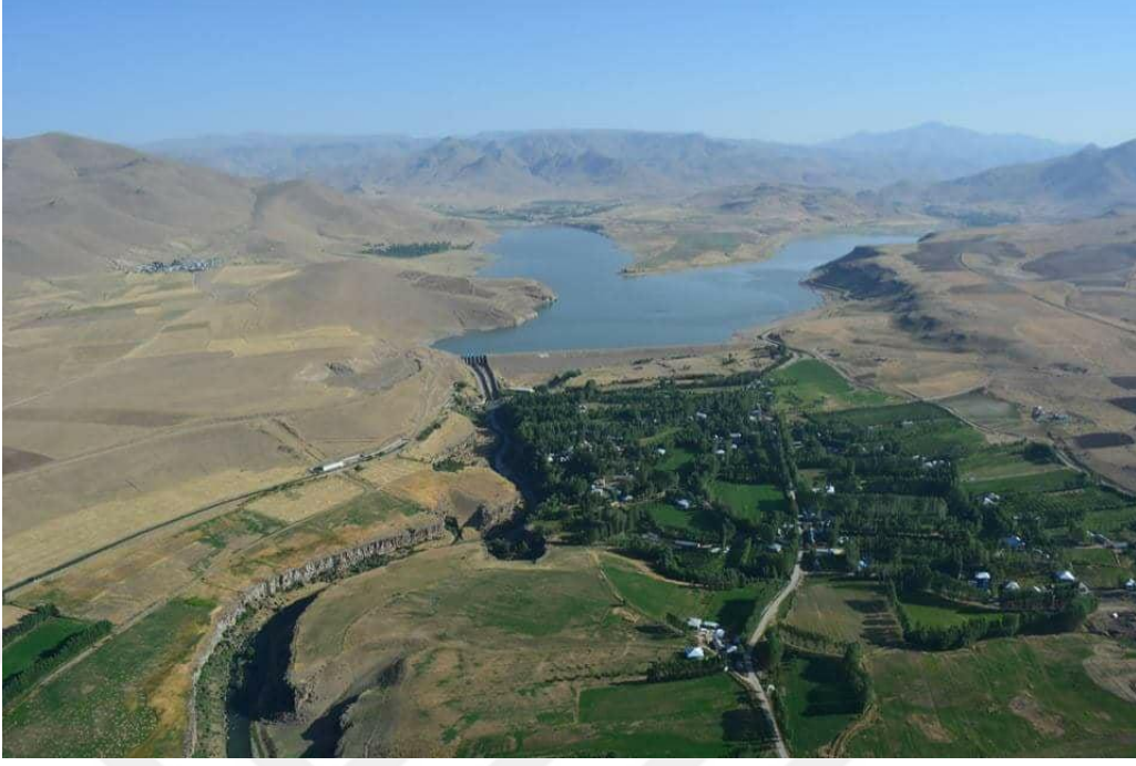
Şekil 3.5. Koçköprü Baraj Gölü'nün güney bölgesinden bir görünüm.
