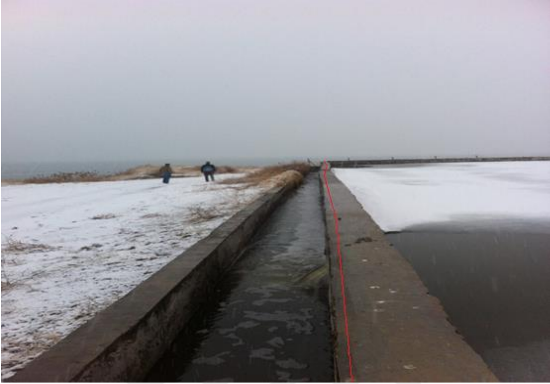
Şekil 1.3. 1994 yılında yapımı tamamlanan eski Erciş Atıksu Arıtma Tesisi havuzunda gözlenen sıvılaşmaya bağlı deformasyonlar.
