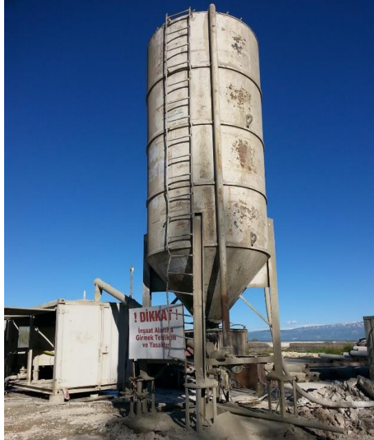
Şekil 1.12. Çimento silosuna ait bir görüntü.
