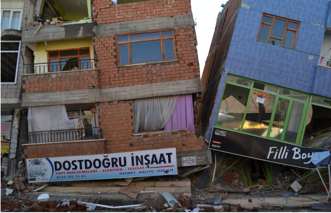
Şekil 1.5. Erciş yerleşim alanında 23 Ekim 2011 yılında meydana gelen deprem sonra sivilaşmaya bağlı gelişen hasara ait bir görüntü.
