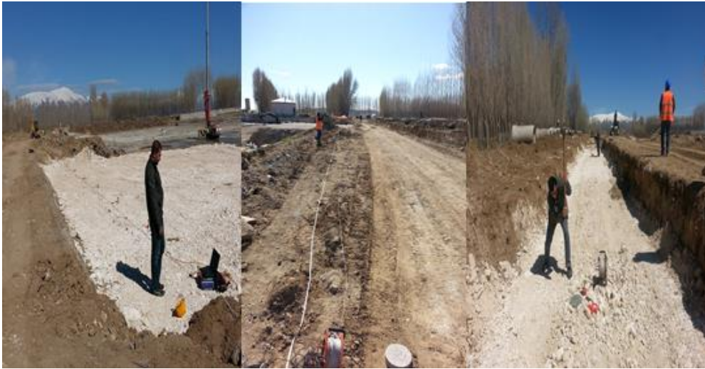
Şekil 4.11. Jet Grout sonrası jeofizik çalışmalara ait bir görüntü.
