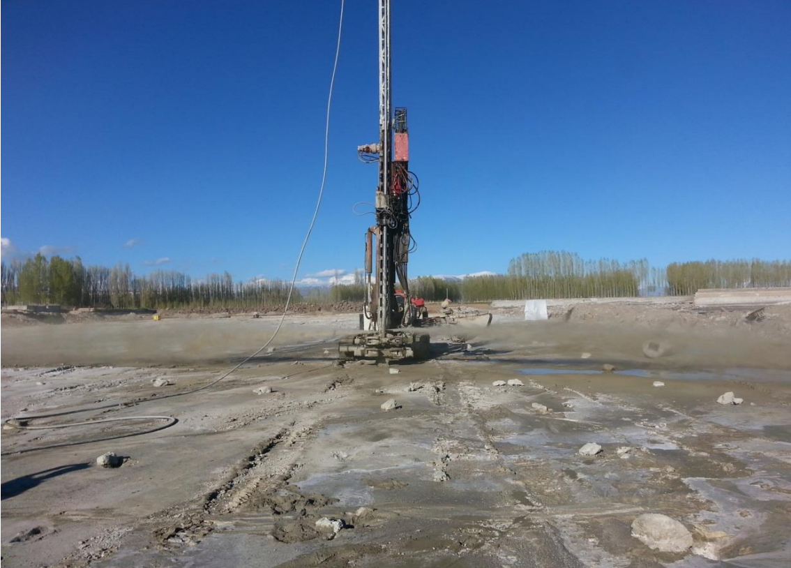
Şekil 1.7. İnceleme alanında yapılan Jet Grout çalışmasına ait bir görüntü.
