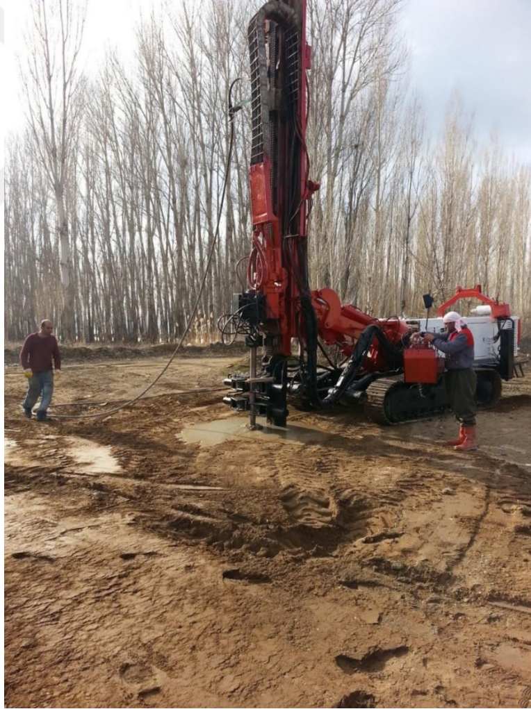
Şekil 1.9. Jet Grout delgi makinesine ait bir görüntü.
