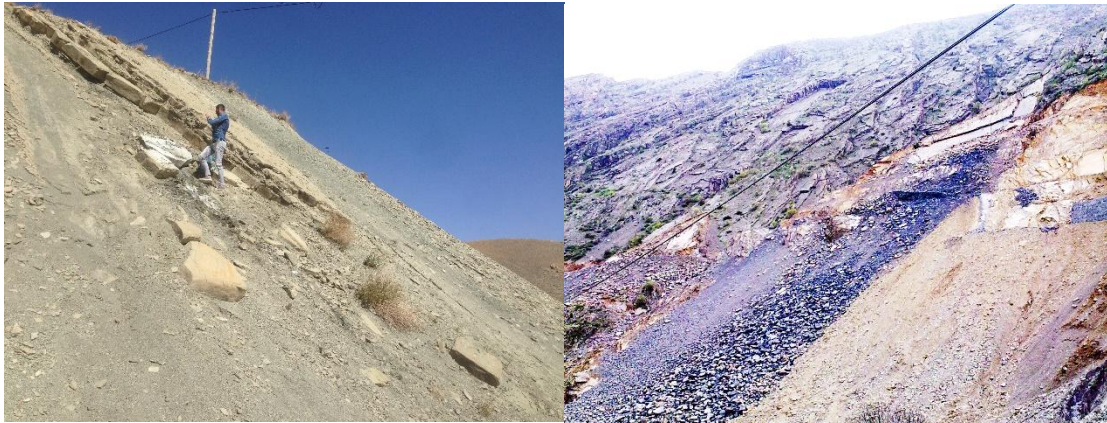
Şekil 4.11. KRBS ve ÇKRC bölgelerinde incelenen şevlere ait bir görüntü.
