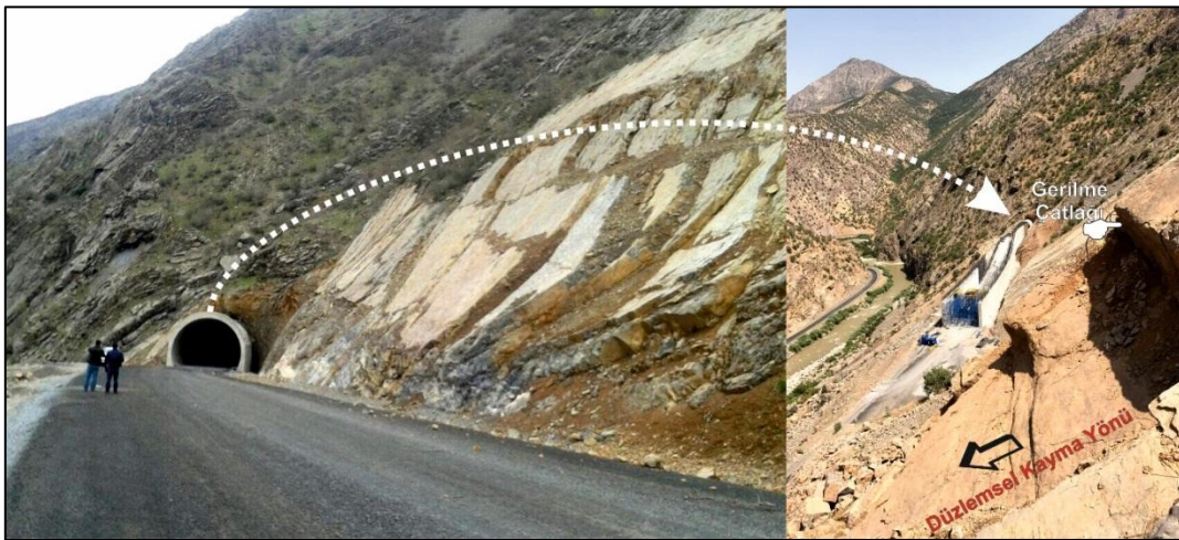
Şekil 4.32. Çukurca Tüneli giriş kısmında ÇKRC düzlemlerinde oluşan düzlemsel kaymalar için alınan önleme ait bir görüntü.
