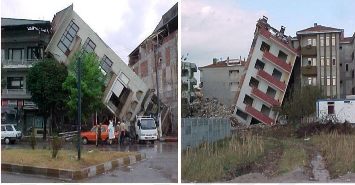
Şekil 3.14. Zemin sıvılaşması nedeniyle hasar gören bina örnekleri.
