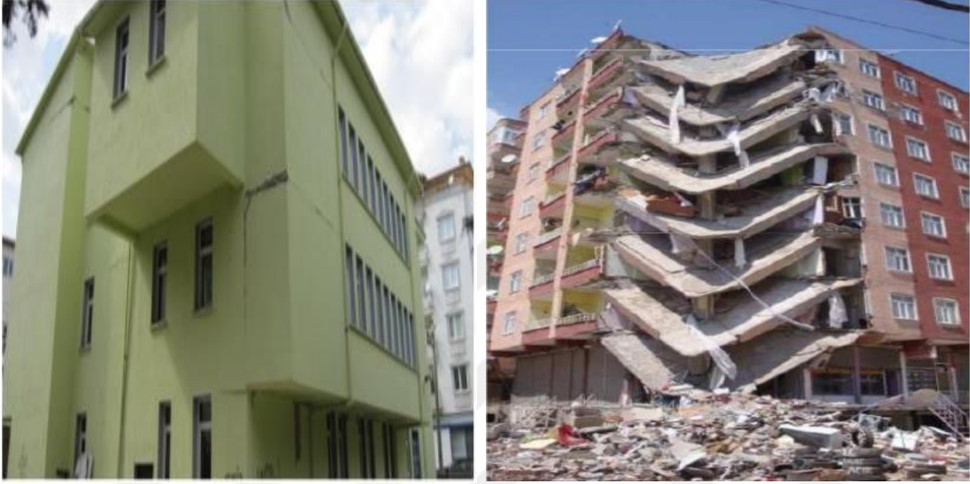
řekil 3.13. Ađır ıkma dzensizliđi nedeniyle hasar gren bina rnekleri.
