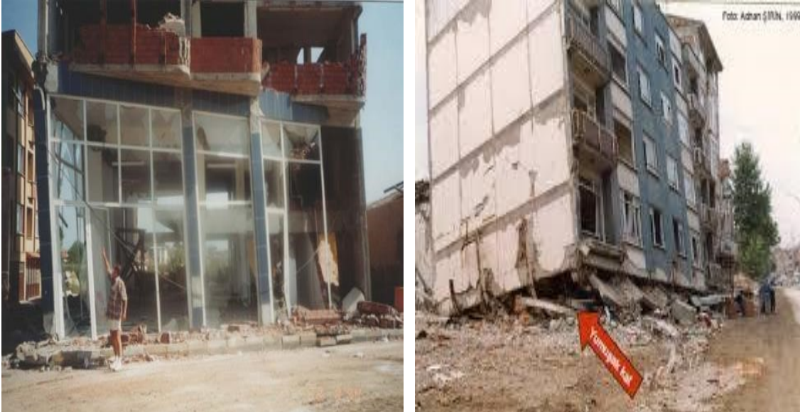
Şekil 3.6. Yumuşak kat düzensizliğinden etkilenen bina örnekleri.
