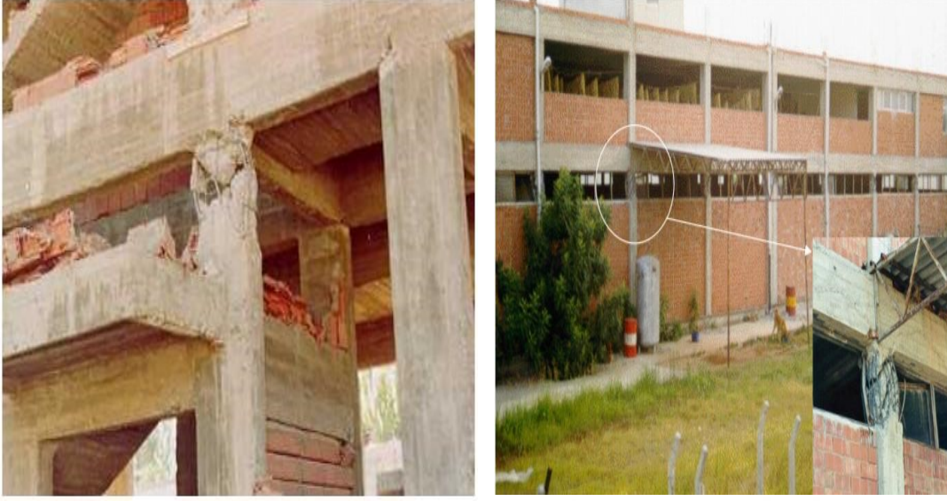
Şekil 3.8. Kısa kolon düzensizliğinden etkilenen bina örnekleri (Çağatay, 2007).
