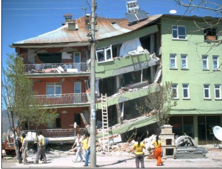
Şekil 3.2. Çarpışma etkisinden kaynaklanan bina hasar durumu (Temür, 2006).
