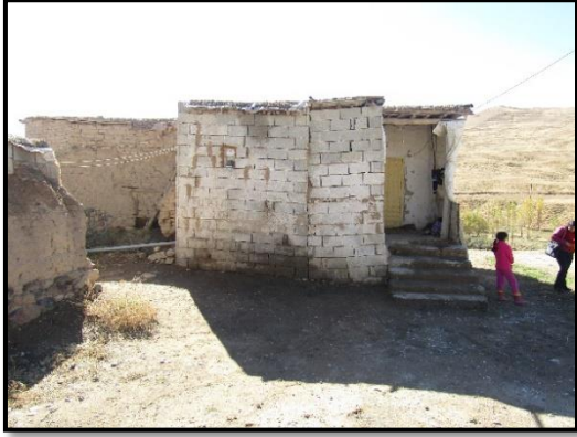
b. Briket bir kısım eklenen giriş cephesi.
