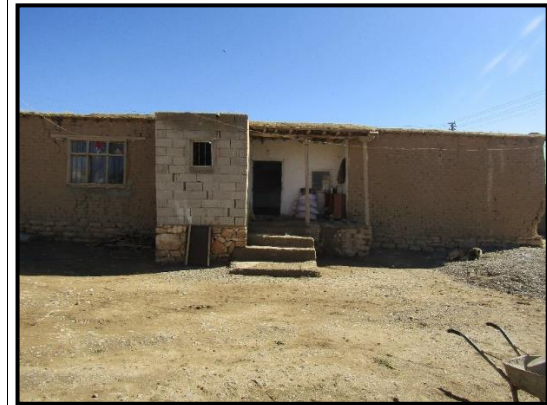
b. Sonradan eklenen briket kısım ile batı cephesi.
