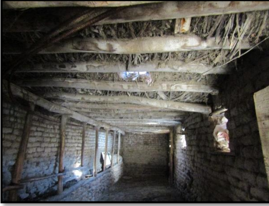
c. Ahır 2 tavan sistemi ile hayvan yem bölümü.
