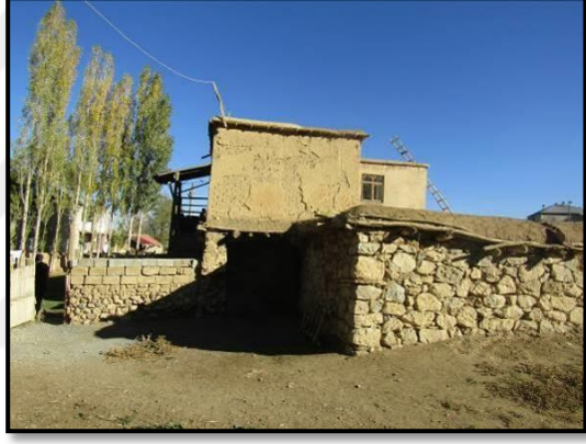
c. Kademeli cephe yapısı ile kuzeybatıdan görünüş.
