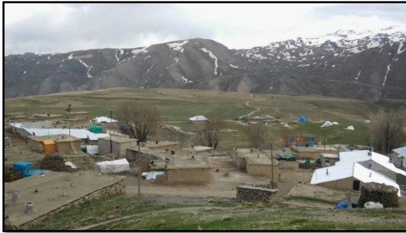
Şekil 5.4. Yerel düz toprak dam konutlar ile sonradan sac çatı yapılan konutların bulunduğu doğa içerisindeki görünümü.
