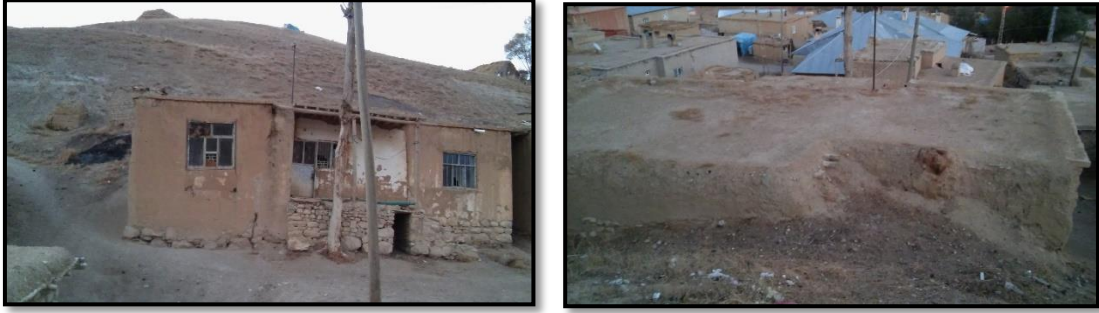
a. Ön (güneydoğu) cepheden bir görünüm. b. Toprağa gömülü haldeki arka (kuzeybatı) cephe. Şekil 4.62. Alaattin Alkan Evi'ne ait fotoğraflar.
