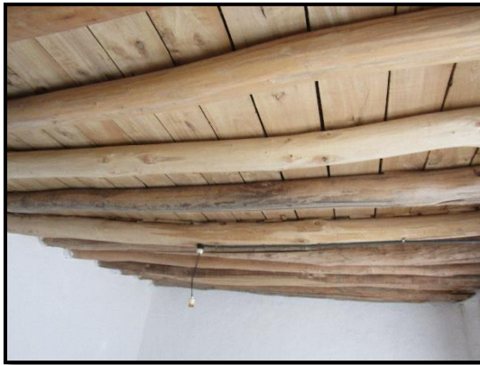
a. Oda üst döşeme ahşap yerleştirme düzeni.
