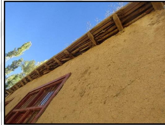
d. Saçak altları ahşap yapım tekniği.
