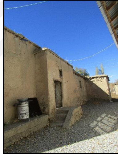
d. Doğu yönünden giriş cephesi.
