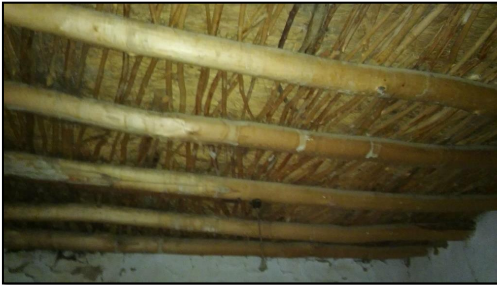
a. Üst döşeme yapım tekniği.
