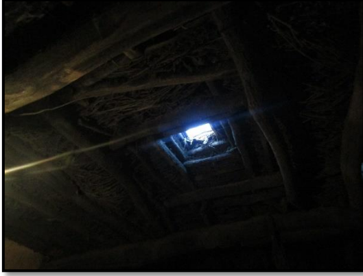
c. Tandır evi üst örtü sistemi ve bacası.
