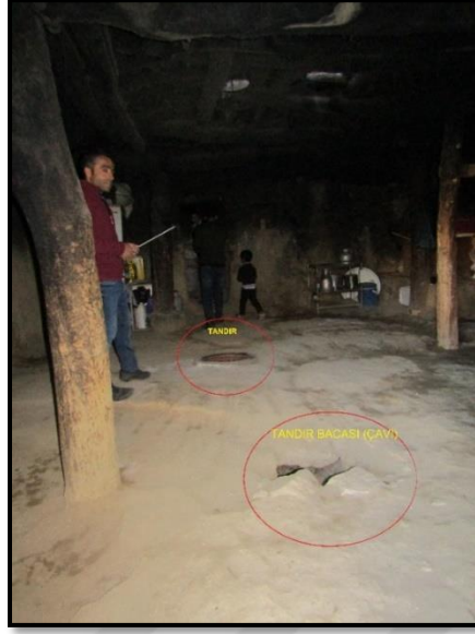
Şekil 5.22. Tandır ve bacası (Tandır ve çavi daire içerisine alınmıştır).
