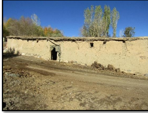
b. Güneydoğu cephesindeki ahır girişi.
