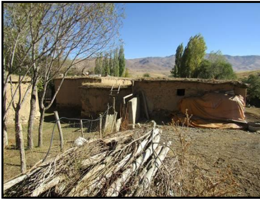
c. Güneybatı yönünden görünüm.
