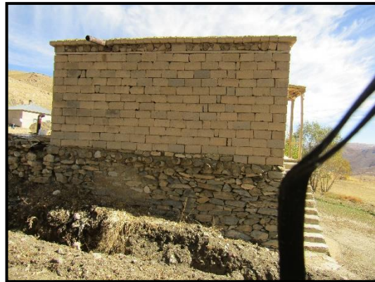
b. Taş duvarın üstüne sonradan eklenen briket oda
