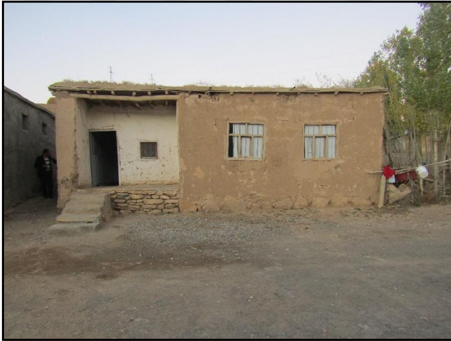
Şekil 4.77. Ferzende Delikurt Evi ön (güney) cephe görünümü.
