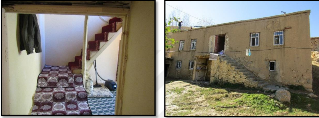
Şekil 5.33. İç ve dış merdiven.
