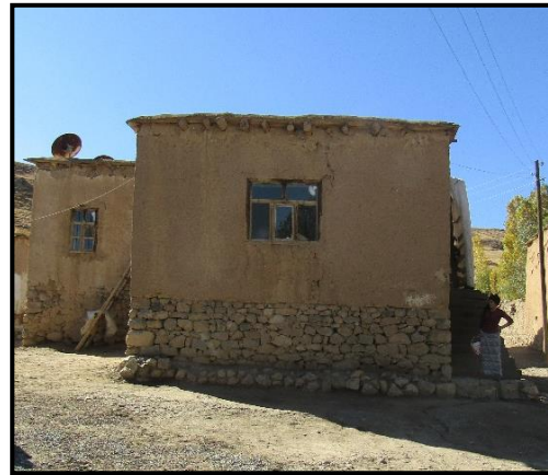
b. Güneydoğu cephesi.
