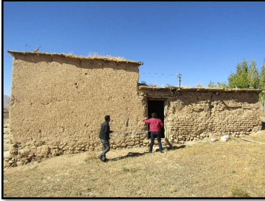
b. Doğu cephesindeki bağımsız tandır evi girişi.
