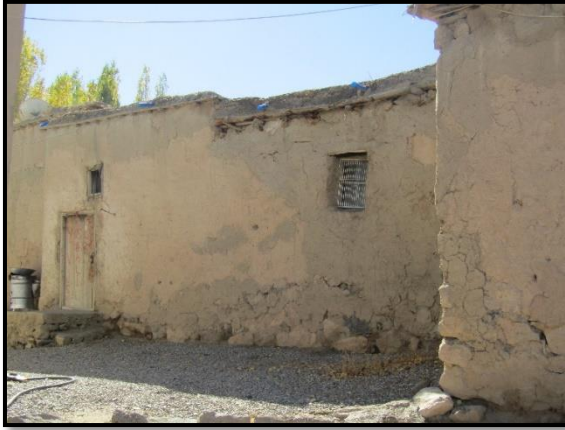
Ön (kuzeydoğu) cephe.
