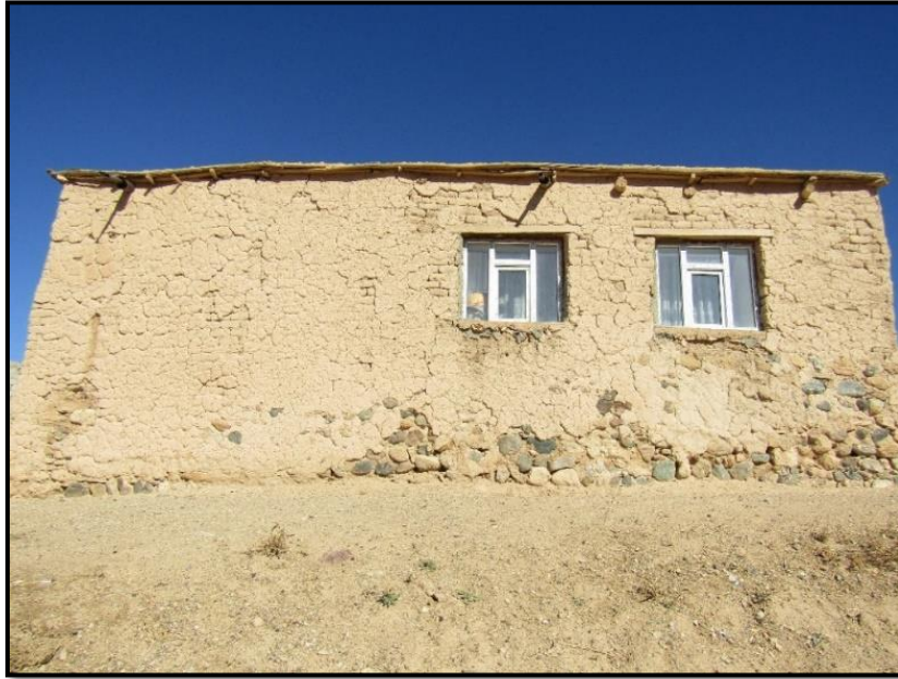
a. Sonradan PVC doğrama pencere takılan güney cephesi.
