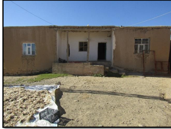
a. Ortalanmış giriş kısmı ile doğu cephesi.
