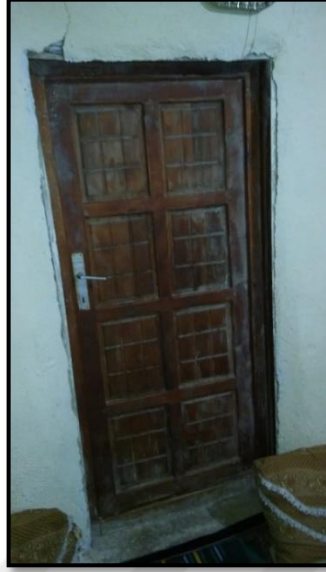
b. Mutfak kapısı
