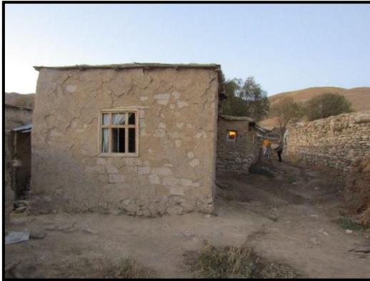
b. Sonradan yapıya eklenen briket oturma odası.
