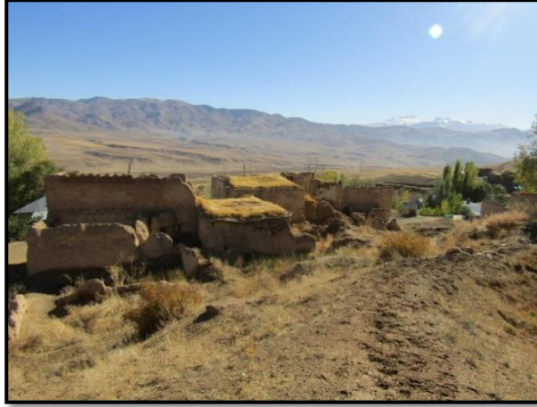
Şekil 5.2. Çeşitli nedenlerle kullanıcısından yoksun kalmış ve yıkılmak üzere olan kırsal konutlar.
