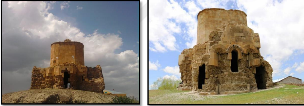
Şekil 4.27. Soreder Kilisesi (Kızıl Kilise) görünümleri (Anonim, 2018f).
