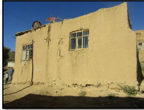
Yapının düz toprak dam görünüşü.
