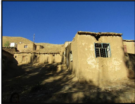
c. Yoldan yapının güney cephesi görünümü.
