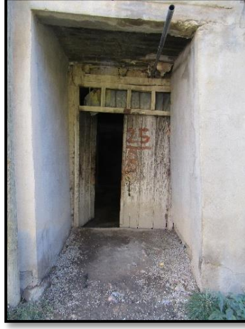
Şekil 5.40. İki kanatlı dış kapı görünümü.
