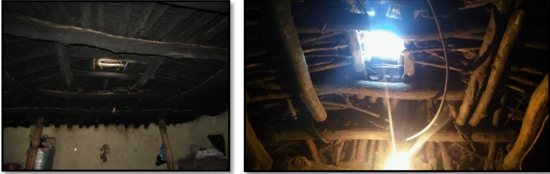
Şekil 5.25. Tandırın bulunduğu kısmın üst örtü sistemi.
