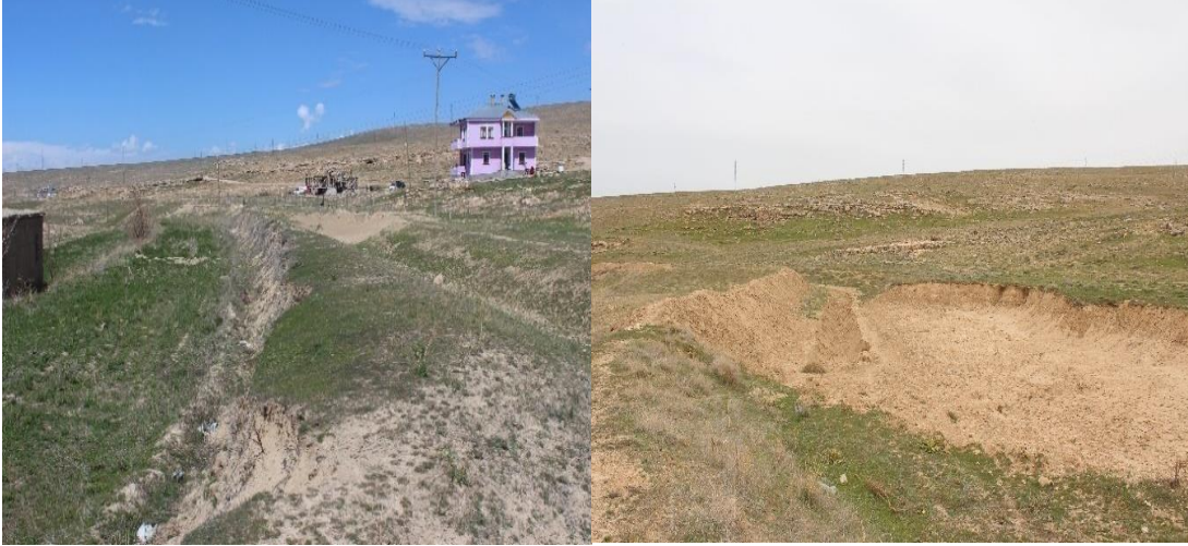
Şekil 4.13. Kanal içinde genişletme çalışmaları sonucu oluşan tahribat. Sağ: kanalın dış eğiminde oluşan tıraşlama tahribatı (Orjinal, 2019).
