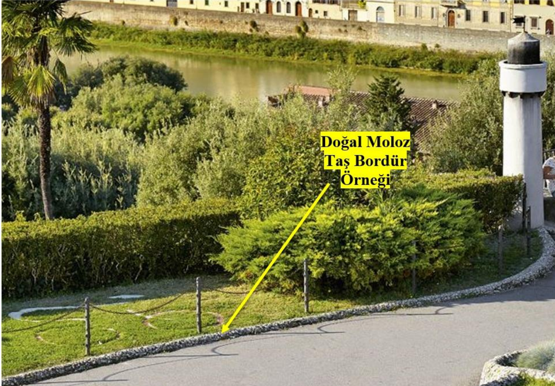
Şekil 5.17. Doğal yeşil alan ile yürüyüş yolunu birbirinden ayırmak için kullanılan doğal blok taşlardan yapılmış bordür örneği (Anonim).
