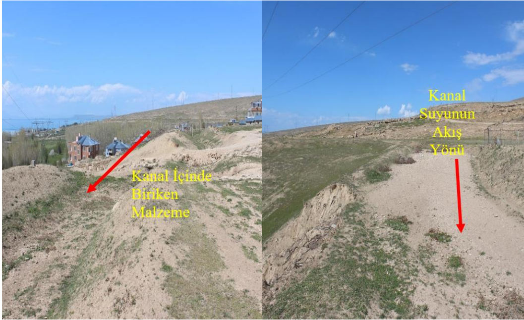
Şekil 4.9. Tepelik alanlardan akan suyun kanal içinde yarattığı tahribatlara ait görseller (DSİ Minua (Şamram) Kanalı Restorasyon Raporu, 2018).
