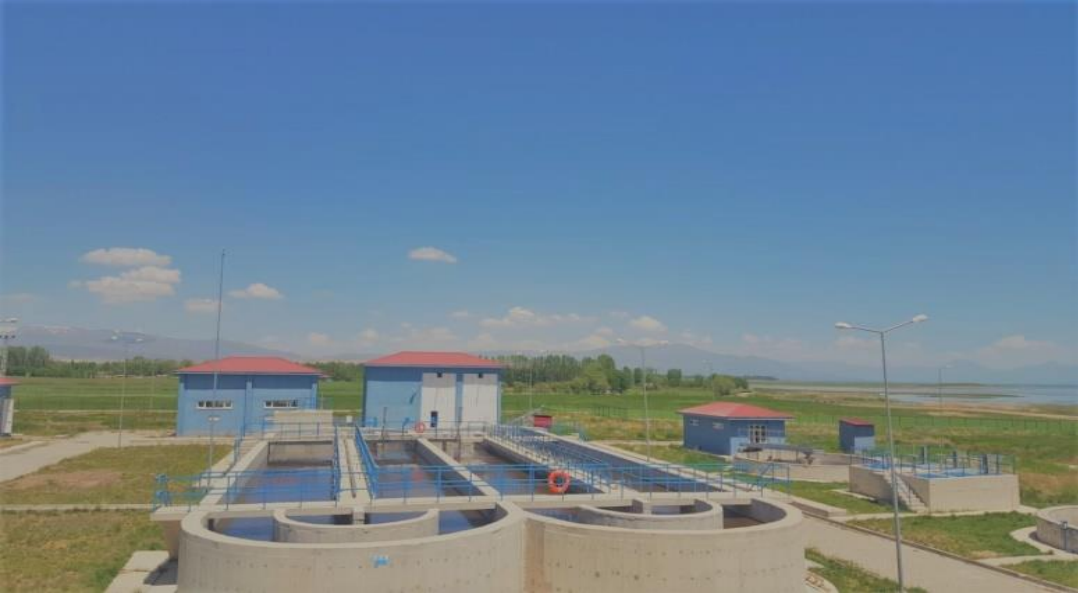
Şekil 3.11. Çelebibağı atıksu arıtma tesisi.
