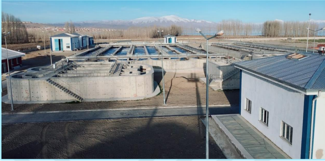
Şekil 3.12. Gölağzı atıksu arıtma tesisi.
