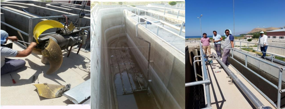
Şekil 4.1. Gevaş A.A.T. havalandırma havuzu difüzör ve mikser onarım çalışmaları
