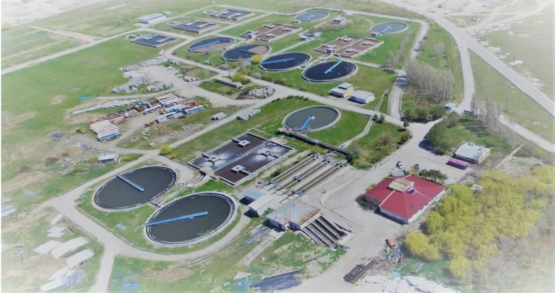
Şekil 3.2. Van İskele atıksu arıtma tesisi.
