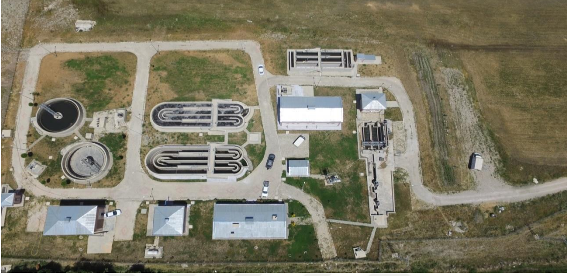
Şekil 3.6. Gevaş atıksu arıtma tesisi.
