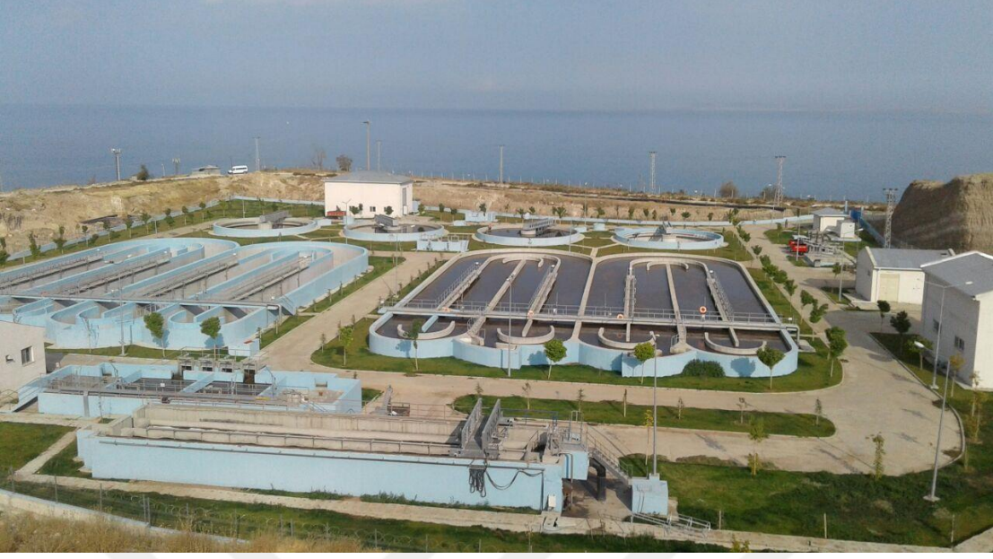
Şekil 3.4. Edremit atıksu arıtma tesisi.
