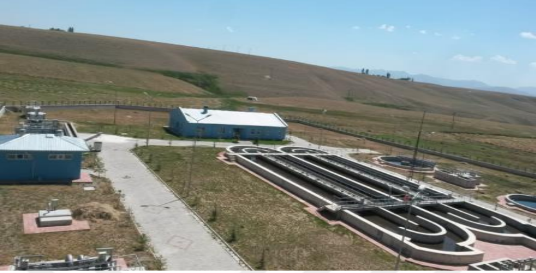
Şekil 3.8. Başkale atıksu arıtma tesisi.
