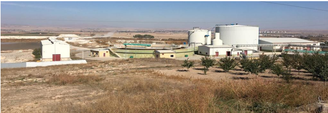
Şekil 3.7.Boğazlıyan şeker ve mamulleri entegre tesisi endüstriyel atıksu arıtma tesisi.
