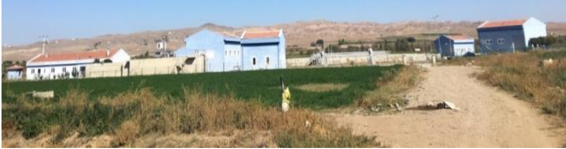
Şekil 3.3.Yerköy Belediyesi biyolojik atıksu arıtma tesisi.
