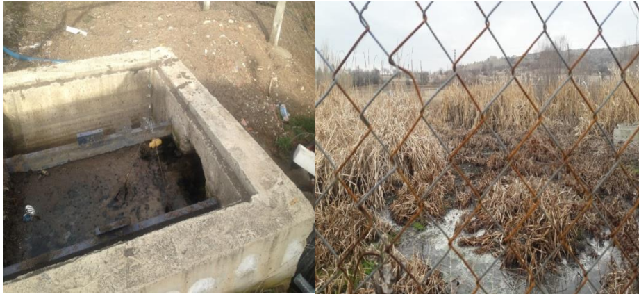
Şekil 2.17. Bakımı yapılmayan yapay sulak alanlardaki işletme problemleri.
