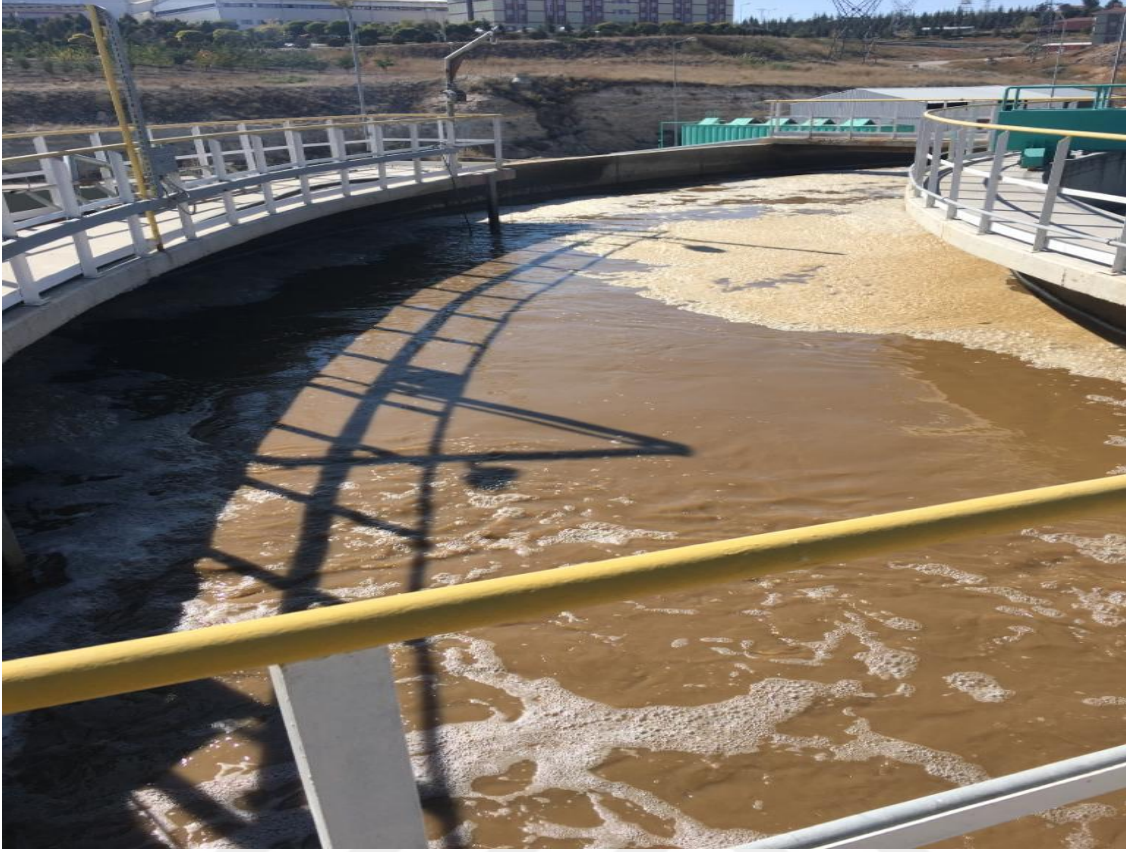
Şekil 4.17.Havalandırma havuzunda köpük.
