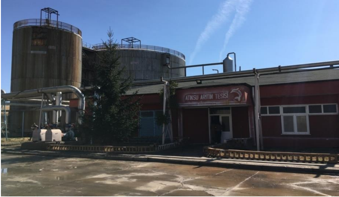
Şekil 3.10.T.Ş.F.A.Ş Yozgat şeker fabrikası endüstriyel atıksu arıtma tesisi.
