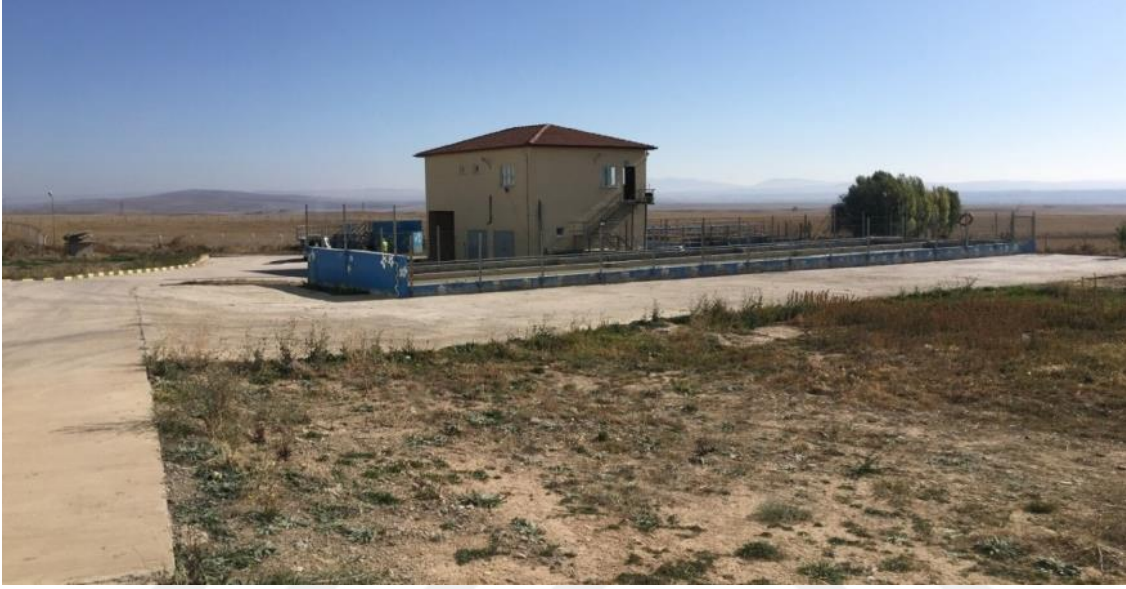
Şekil 3.6.Gedaş genel gıda dağıtım pazarlama san. ve tic. a.ş. atıksu arıtma tesisi.
