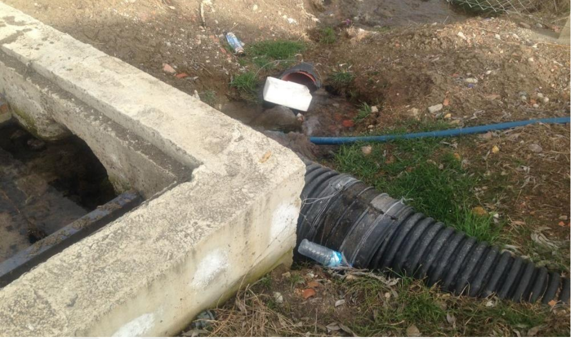
Şekil 2.16.Yapay sulak alan çıkış yapısı.
