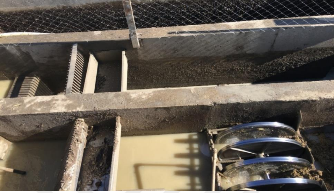
Şekil 4.13.Döner tambur ızgarada katı madde birikimi.
