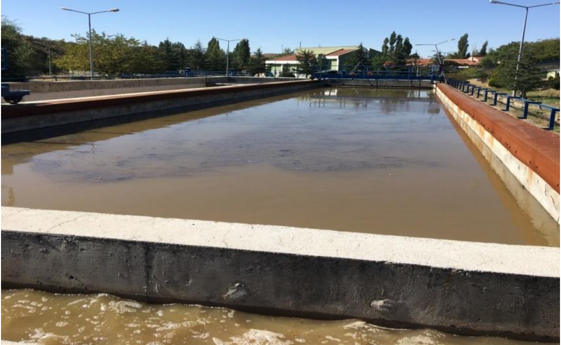
Şekil 4.2.Ön çökeltme havuzunda yüzücü çamur.
