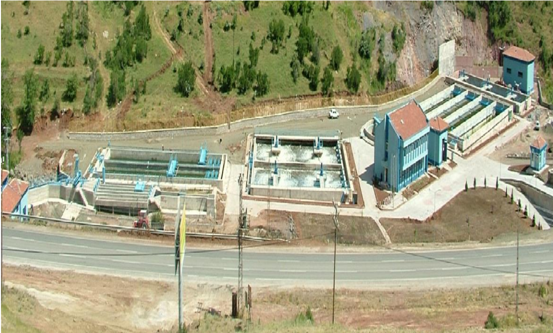
řekil 3.1.Yozgat Belediyesi biyolojik atıksu arıtma tesisi.
