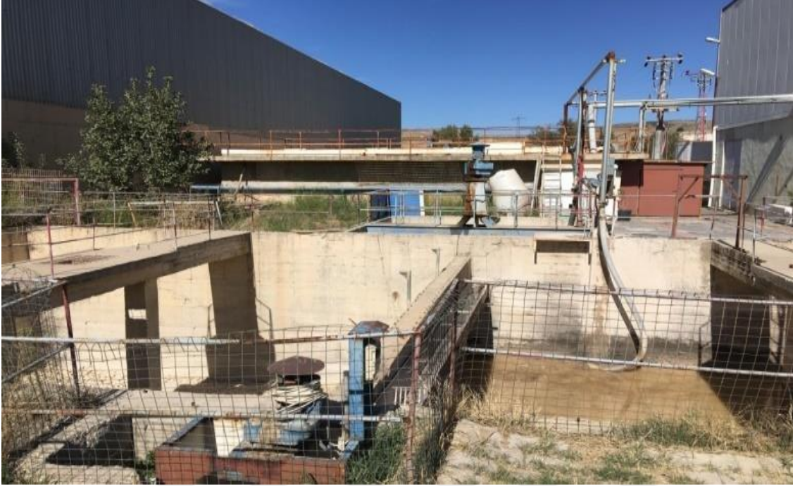
Şekil 4.22. Atıksu giriş yapısı.
