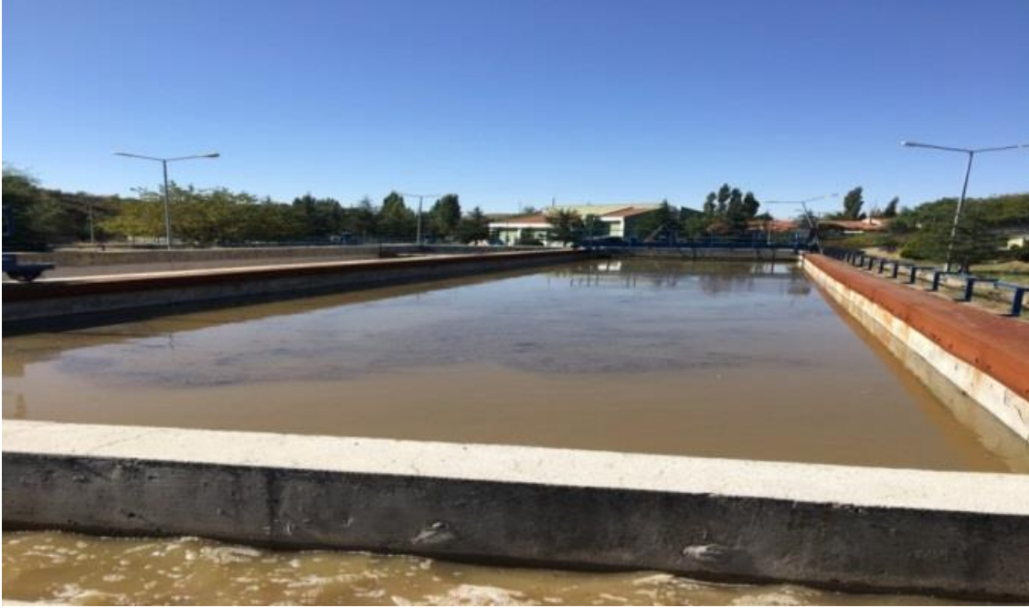
Şekil 2.7.Ön çökeltme havuzunda yüzen çamur.
