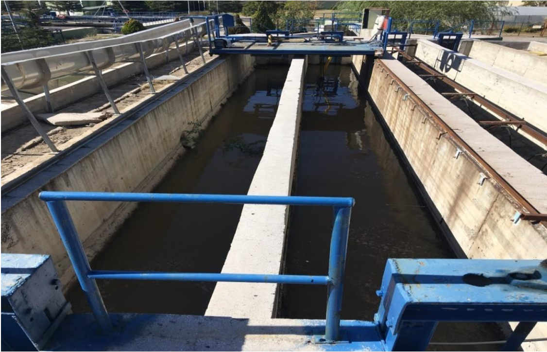
Şekil 2.5.Kum tutucudaki birikimler.
