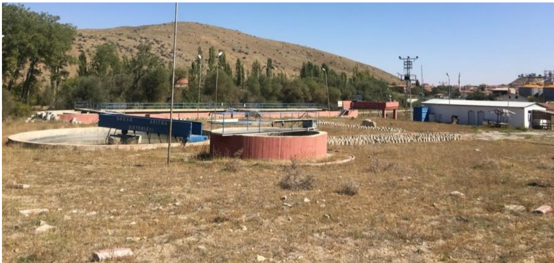
Şekil 3.4.Şefaattli Belediyesi biyolojik atıksu arıtma tesisi.
