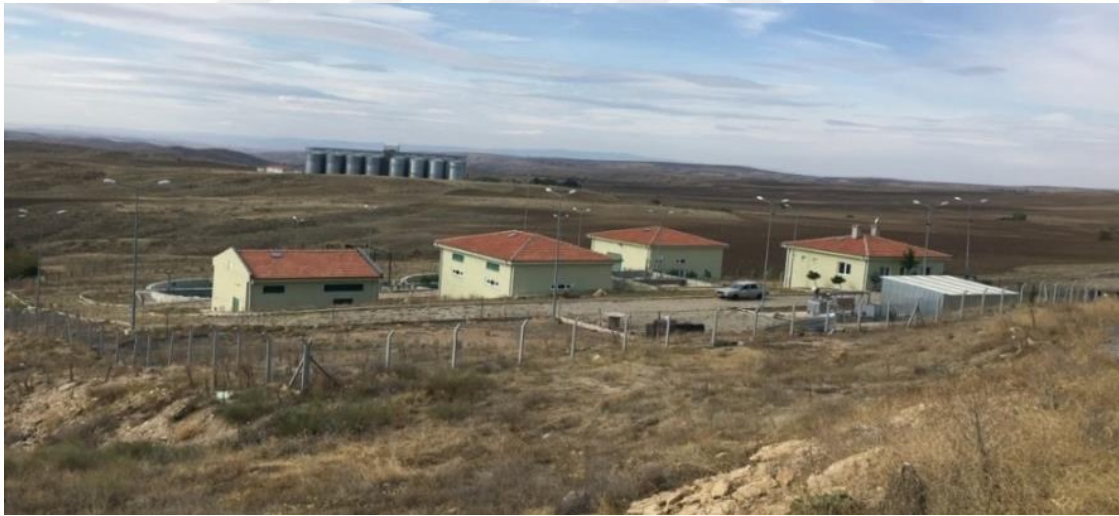
Şekil 3.2.Bozok Üniversitesi atıksu arıtma tesisi.
