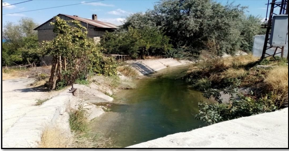
Şekil 4. 6. Edremit ilçesi içerisinde Şamran Kanalı.
