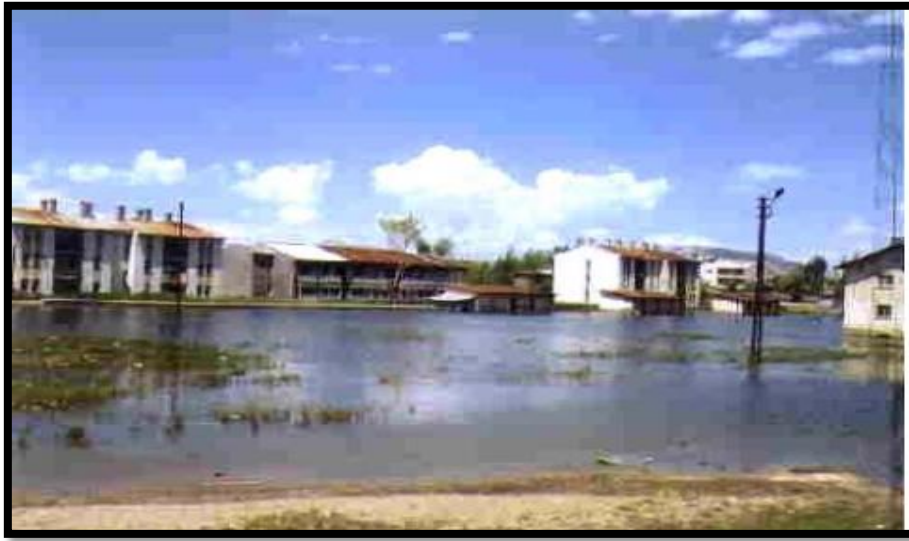
Şekil 4.37. İskele Mahallesi'nde afetten etkilenen konutların görünüşü (Türkelli ,1995).
