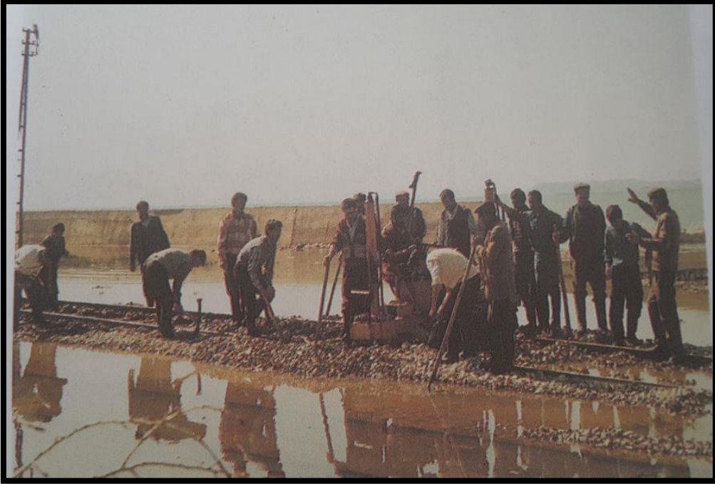
Şekil 4.35. Demir yolunun onarımı görünüşü (Türkelli , 1995).
