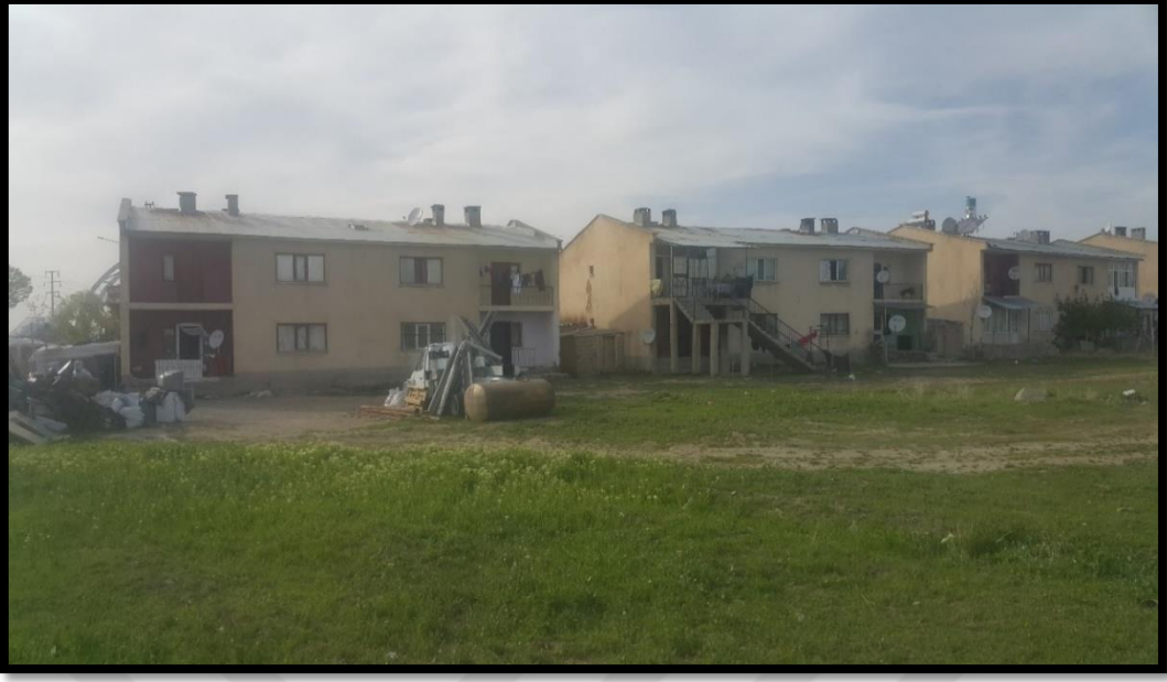
Şekil 5.10. Yapıya sonradan dâhil edilen kapı ve merdivenlerin görünüşü.
