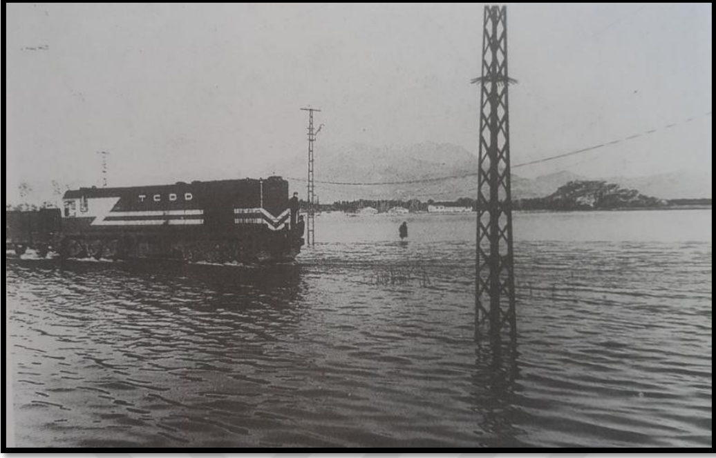
Şekil 4.30. Sular altında kalan tren yolu görünüşü (Türkelli, 1995).
