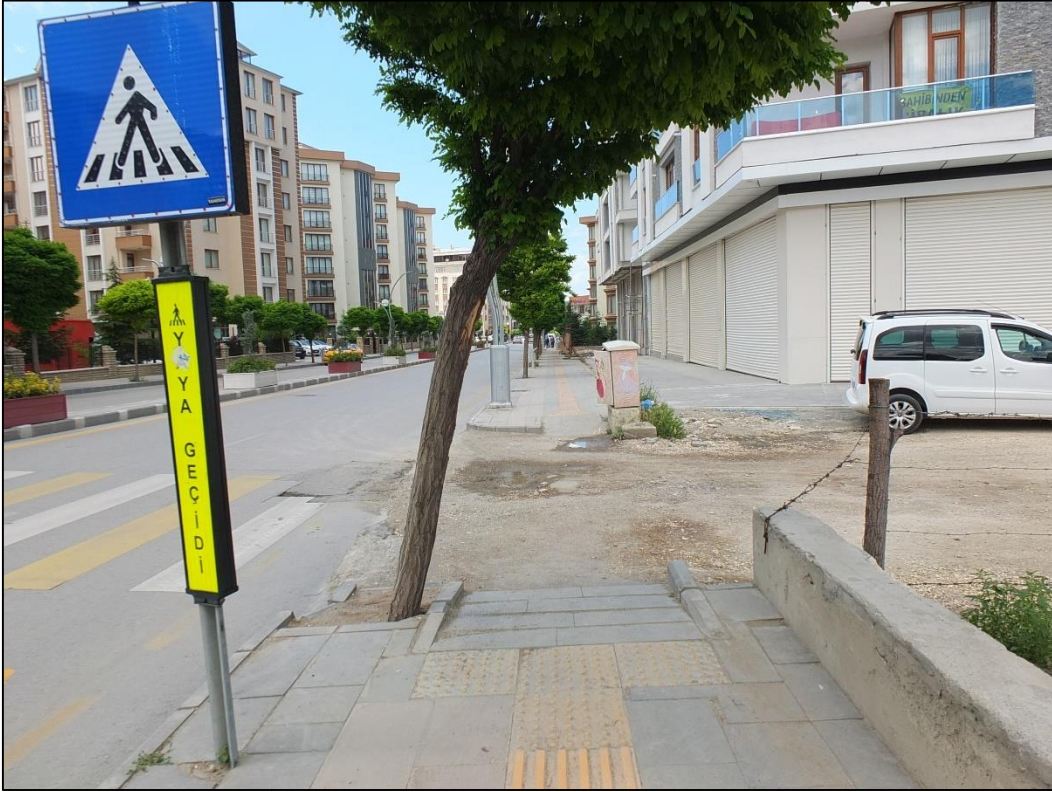
Şekil 4.81. Yaya kaldırımlarındaki rampalar.
