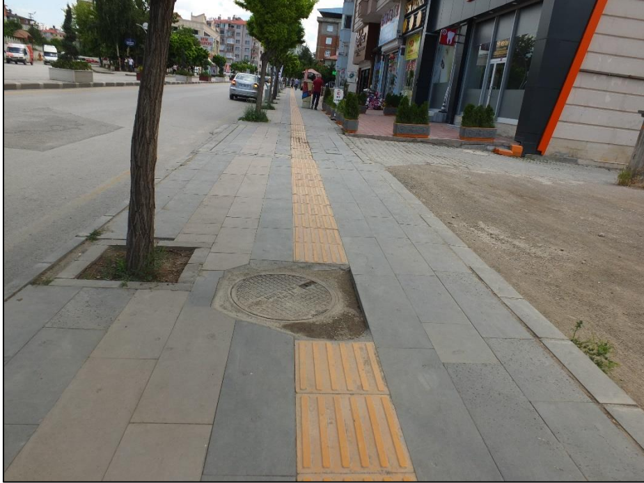
Şekil 4.82. Görme engelliler için yapılan hissedilebilir yüzeyin kesintiye uğraması.
