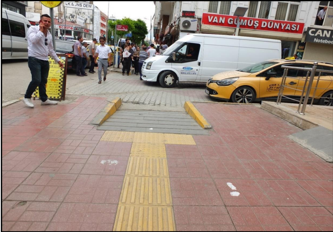
Şekil 4.23. Yaya kaldırımlarındaki rampalar.
