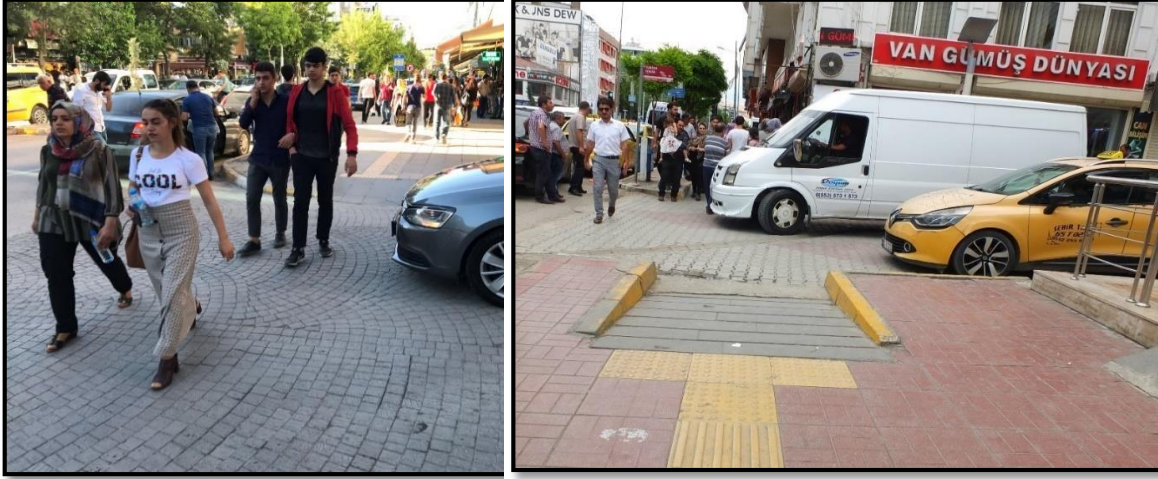
Şekil 4.7. Taşıt-yaya kesişim noktalarında yayaların güvenli geçişini sağlayacak düzenlemelerin eksikliği.
