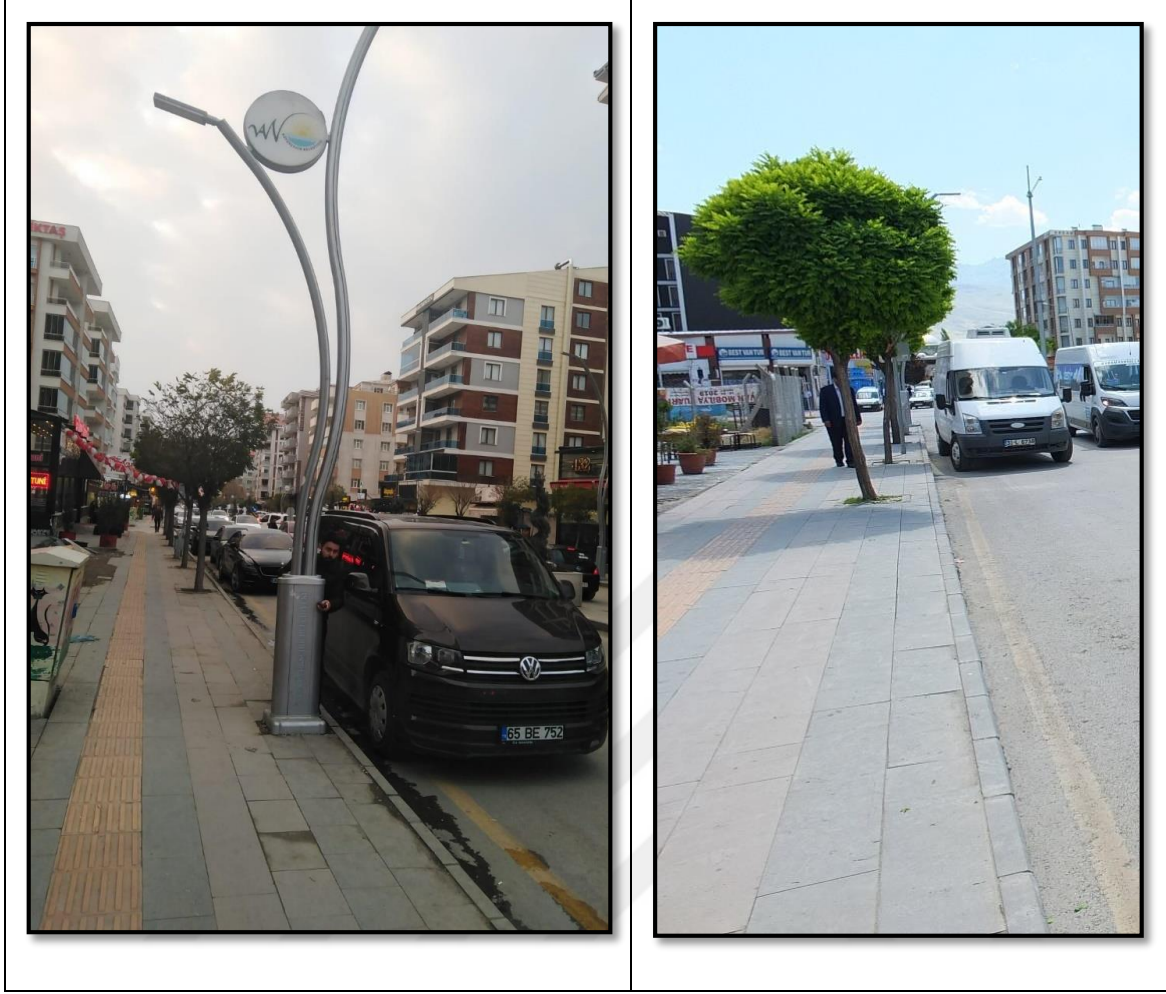
Şekil 4.69. İki Nisan Bulvarı yaya kaldırımı.
