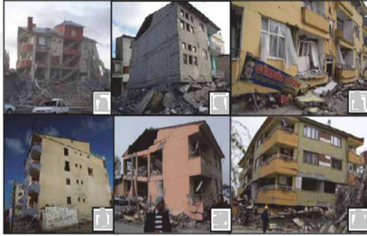
Şekil 2.9. Yumuşak kat etkisinden dolayı göçen binalar (ODTÜ-DMAM,2012).
