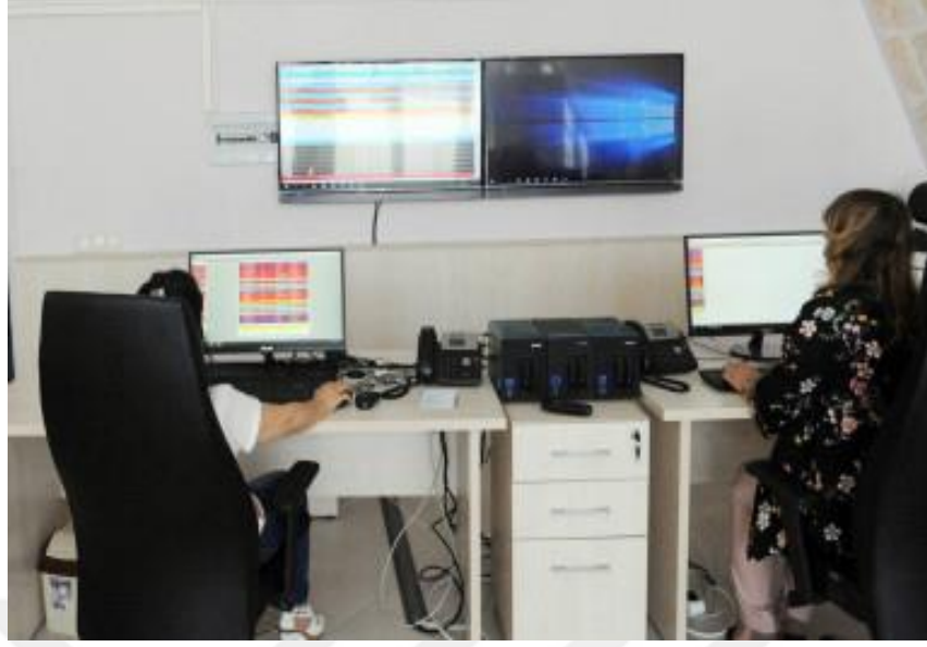
Fotoğraf 3. Akıllı Yaşlı Bakım ve Koordinasyon Merkezi'nin Çağrı Merkezi ve Ekran Takip Ünitesi
