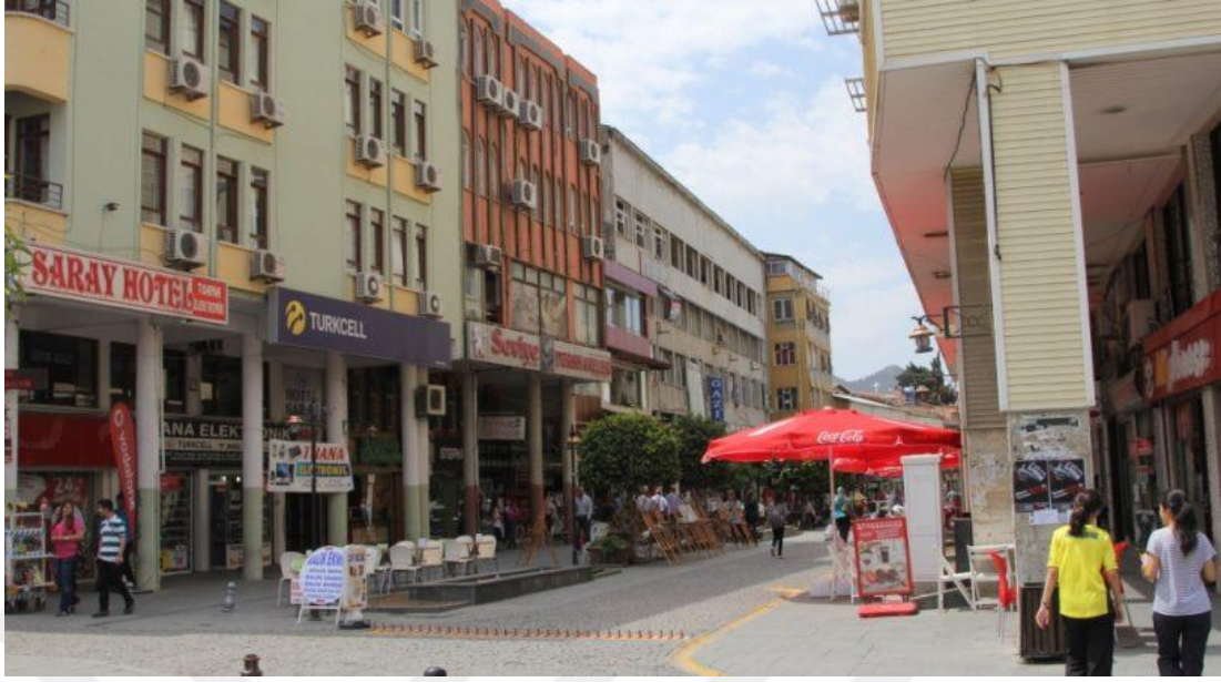
Şekil-6. Cami-i Kebir Çevresindeki Vakıf Binaları
