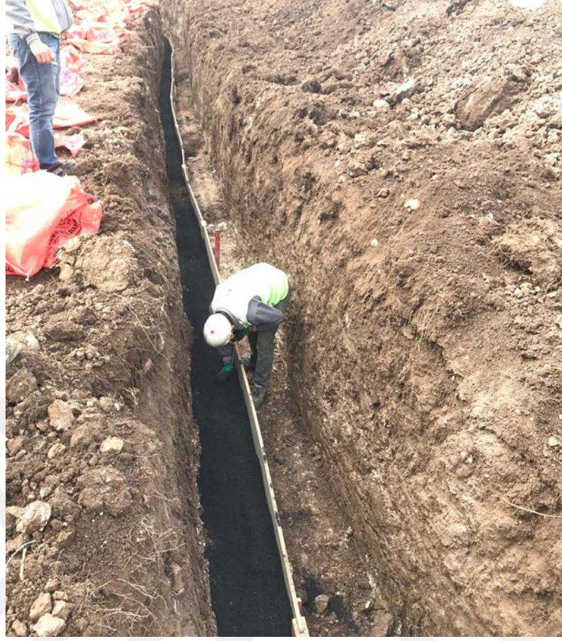
Şekil 4.14. HSI anotlar için karbonlu anot yatağı
