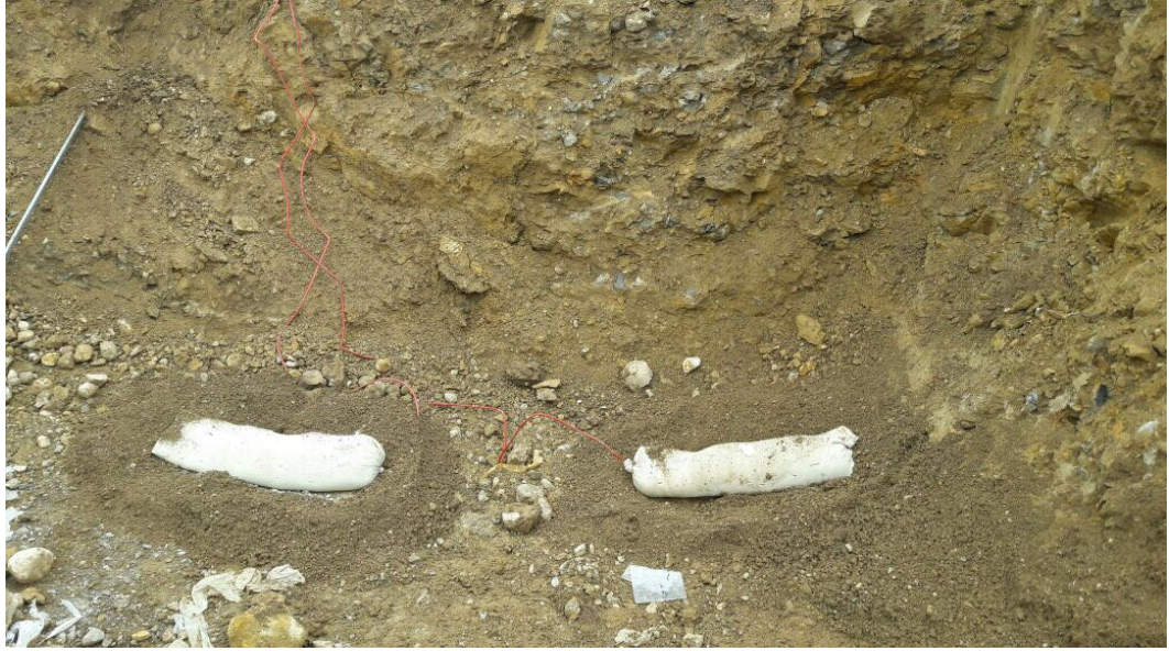
Şekil 4.33. Çift paketli anot kurulumu
