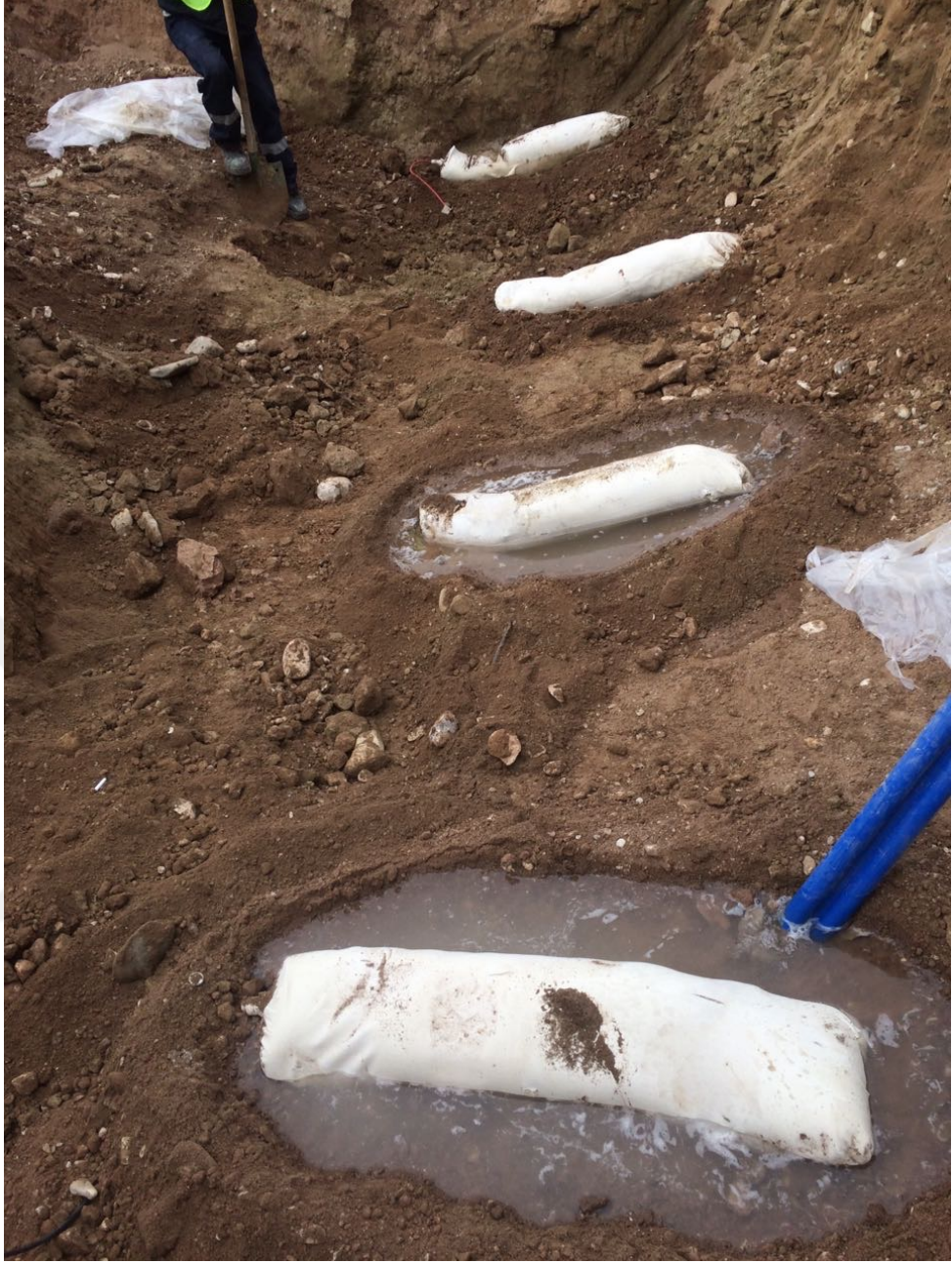
Şekil 4.35. Çoklu galvanik anot kurulumu – 2
