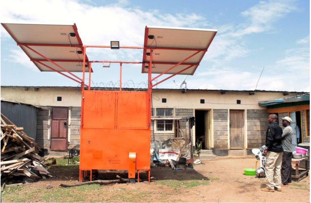
Şekil 1.3. PowerGen firmasının "PowerBox" birimi; 1.4 kW'lık güneş panelleri, 9kWh'lik piller ve 3kW'lık bir çevirici içeriyor.
