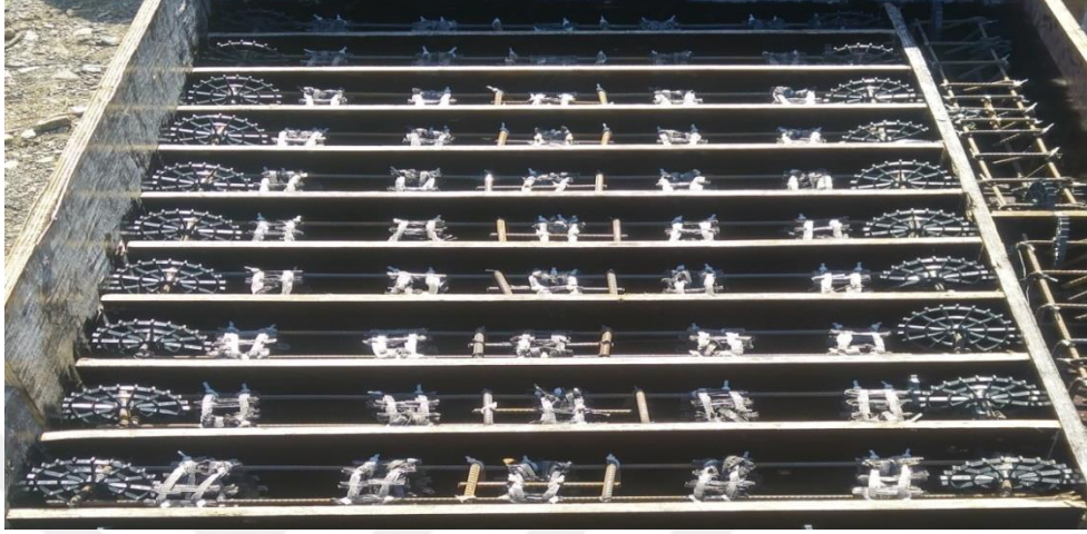
Şekil 4.1. Beton dökümü için hazırlanan kalıplar
