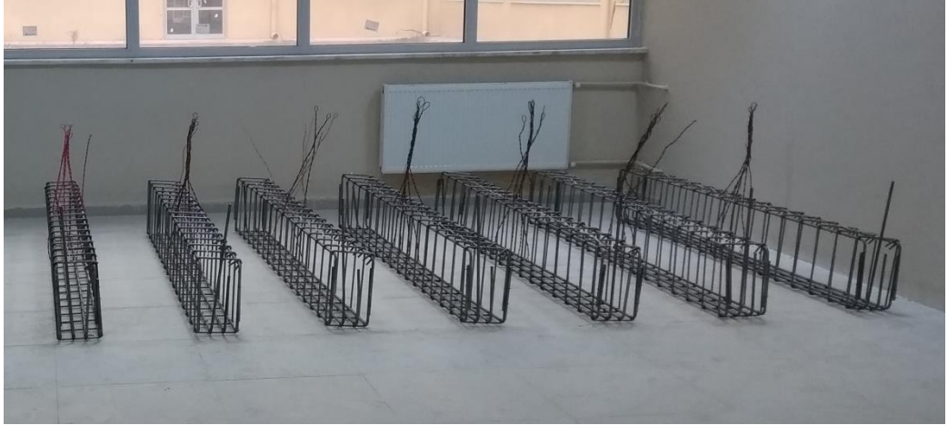
Şekil 4.8. Betonarme Kirişlerin Donatı Kafesleri
