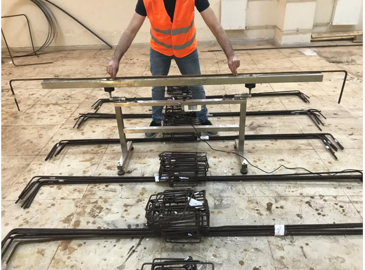
Şekil 5.9. Korozyon Ürününden Arındırılan Betonarme Donatılarının Tartılması
