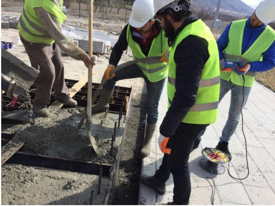
Şekil 4.10. Beton Döküm İşlemi
