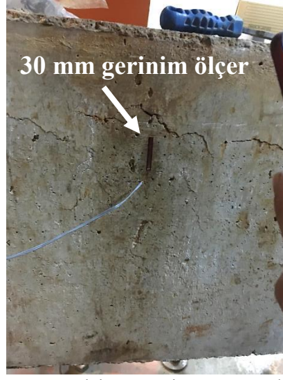
Şekil 4.23. Betonarme kiriş yüzeyine yapıştırılan gerinim ölçer
