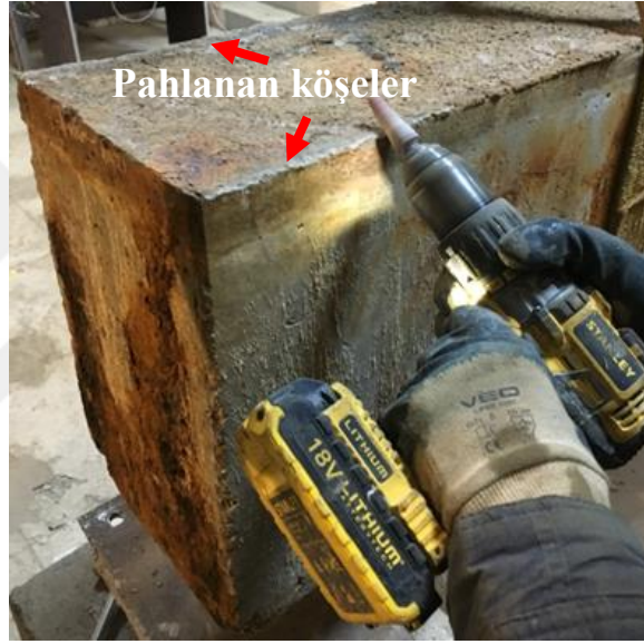
Şekil 4.18. Kiriş Kenarlarının Pahlanması (oval yapılması)
