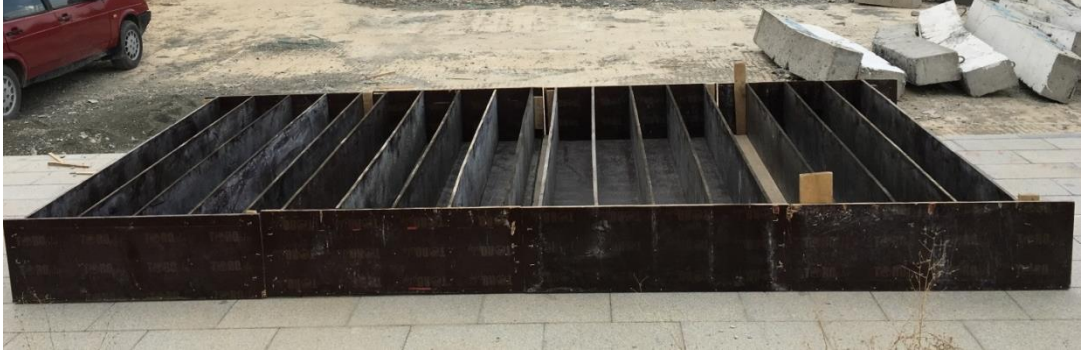
Şekil 4.9. Betonarme Kirişler İçin Hazırlanan Kalıplar
