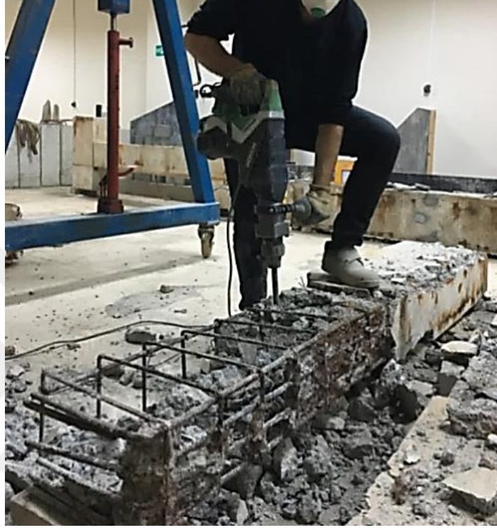
Ŗekil 5.4. Betonarme KiriŖlerin Kırımı.
