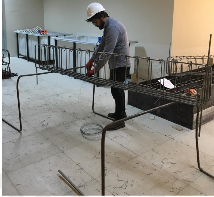
Şekil 4.7. Betonarme Kiriş Donatılarının Bağlanması
