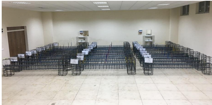
Şekil 3.7. Hazır hale getirilen betonarme kolon donatı kafesleri.
