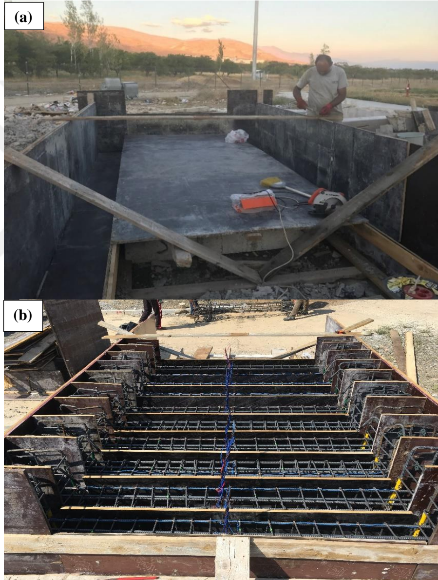
Şekil 3.8. Kalıp işleri: (a) Betonarme kolonlar için hazırlanan kalıplar, (b) Hazırlanan donatı kafeslerinin kalıba yerleştirilmesi.
