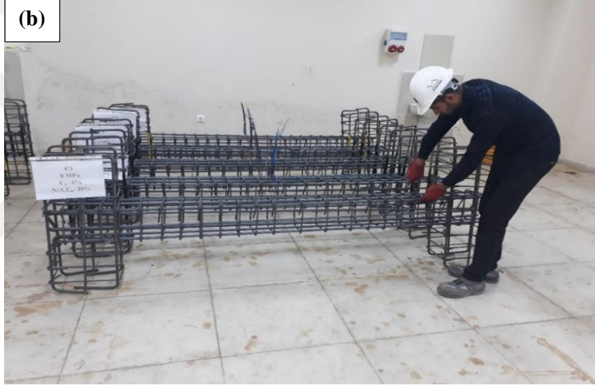
Şekil 3.6. Betonarme kolonların donatılarının bağlanması.
