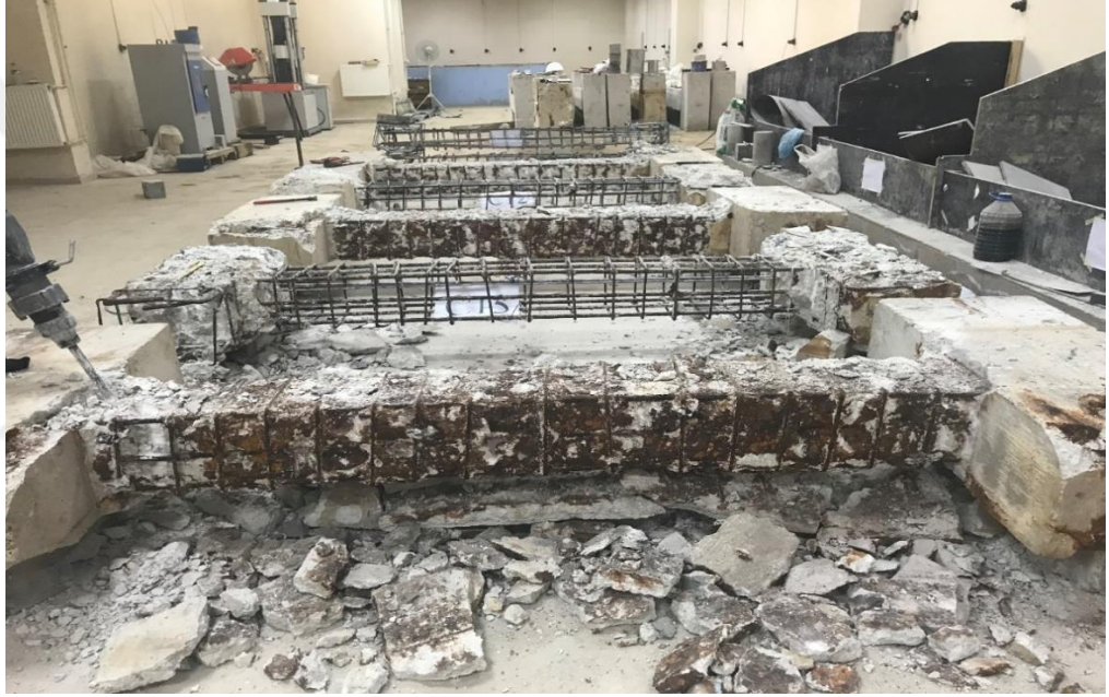
Şekil 4.1. Betonarme kolonların yükleme deneylerinden sonra kırılma işleri.
