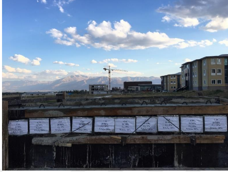
Şekil 3.10. Beton dökümü C30 beton için.
