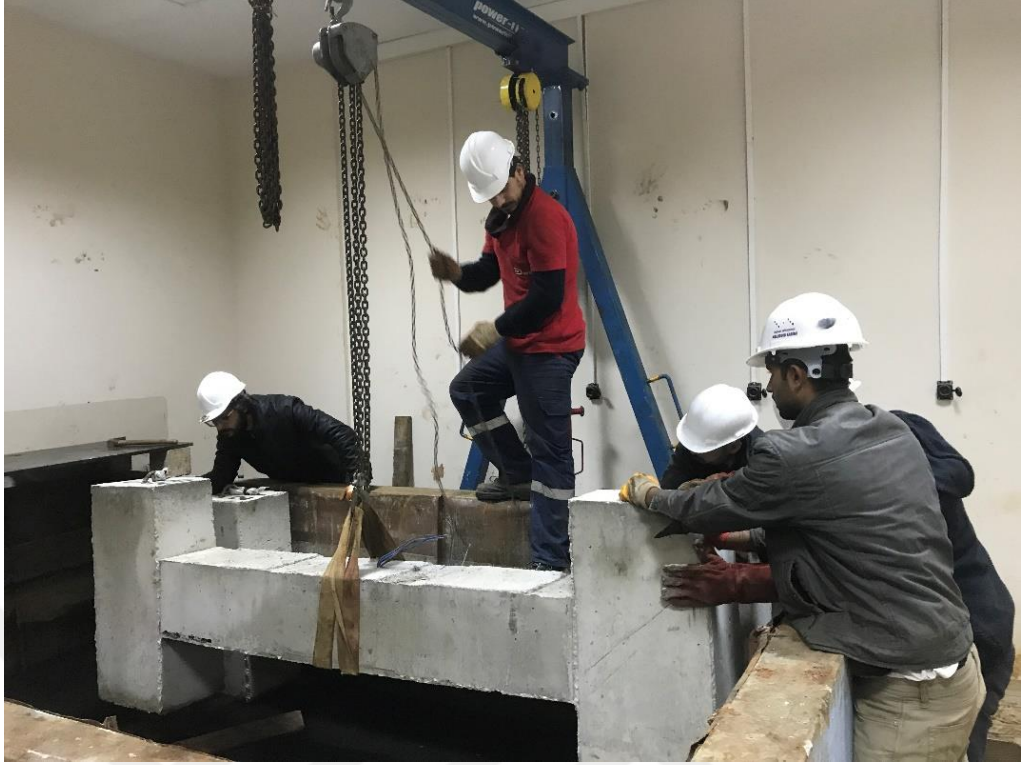
Şekil 3.14. Betonarme kolonların betonarme havuzuna taşınması.
