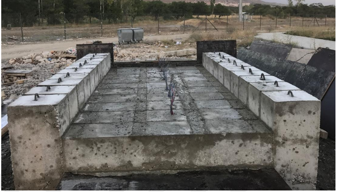
Şekil 4.17. Kalıptan çıkartılan betonarme kolonlar.
