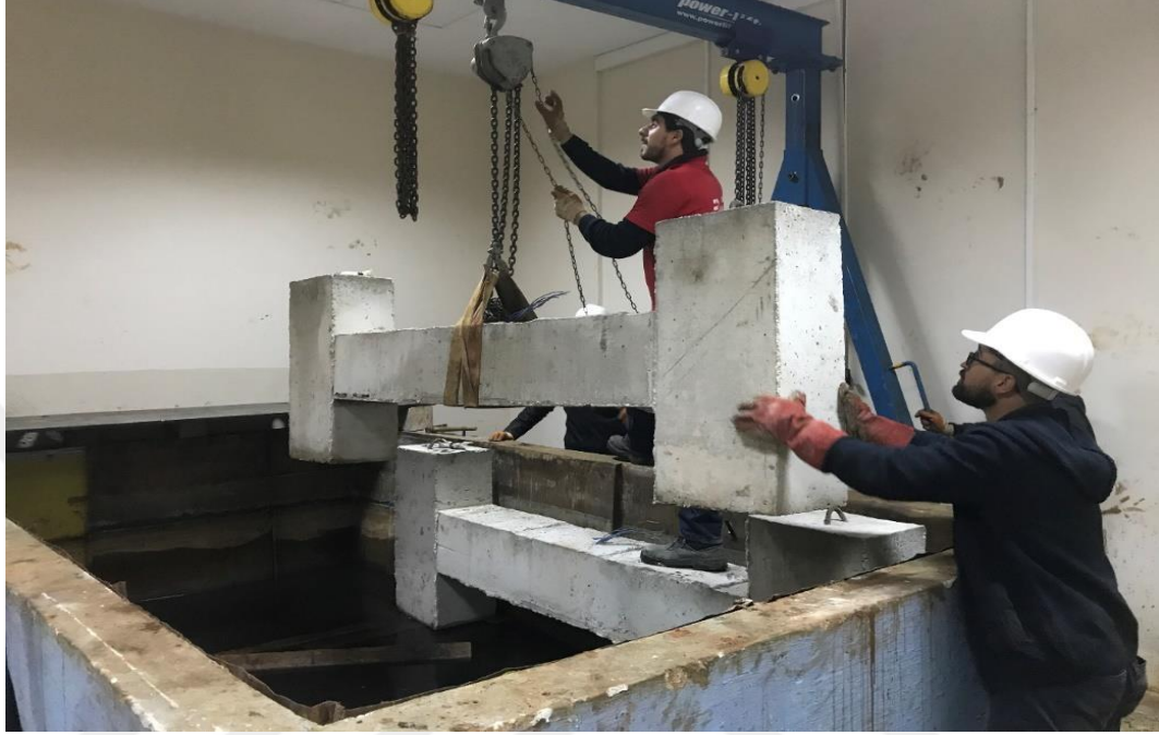
Şekil 4.19. Betonarme kolonlarının paslandırma havuzuna taşınması.
