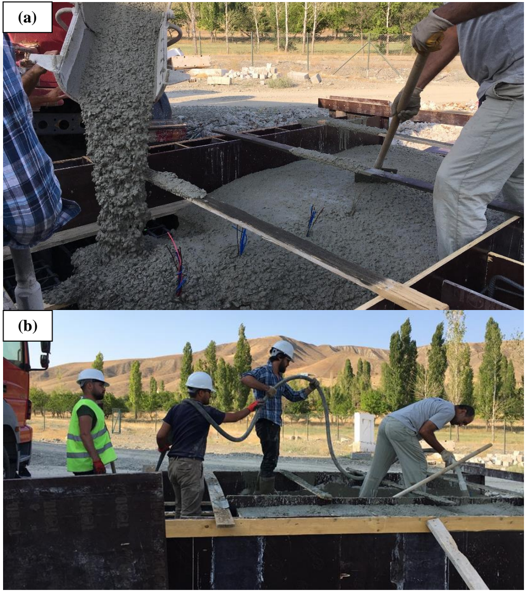
Şekil 4.15. Betonarme kolonlarının beton dökümü: (a) beton döküm işlemleri, (b) betona vibratör kullanımı.
