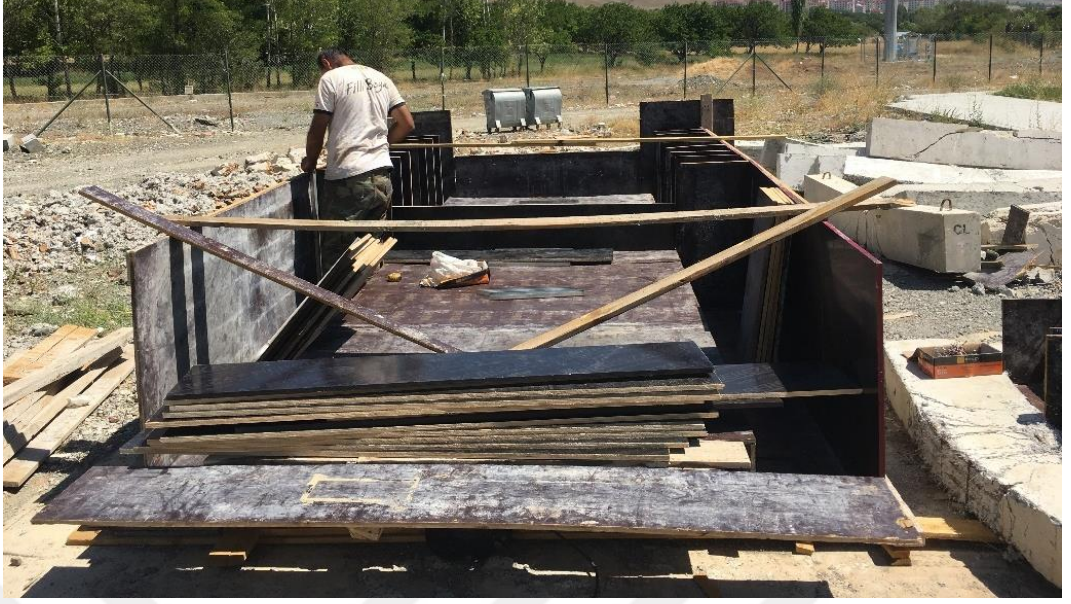
Şekil 4.13. Betonarme kolonları için kalıp hazırlanması.
