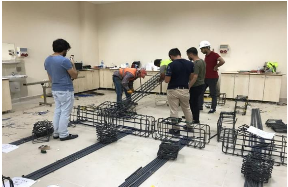
Şekil 4.9. Bakış açısına göre boyuna donatılarının bağlanması.
