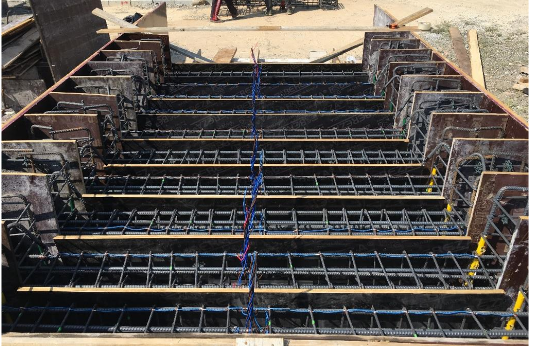
Şekil 4.14. Betonarme kolon donatı kafeslerin kalıba yerleştirilmesi.
