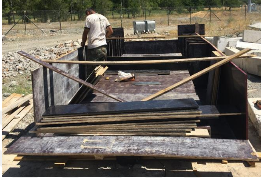
Şekil 4.24. Kolon numuneler için montajı yapılan betonarme kalıplar.
