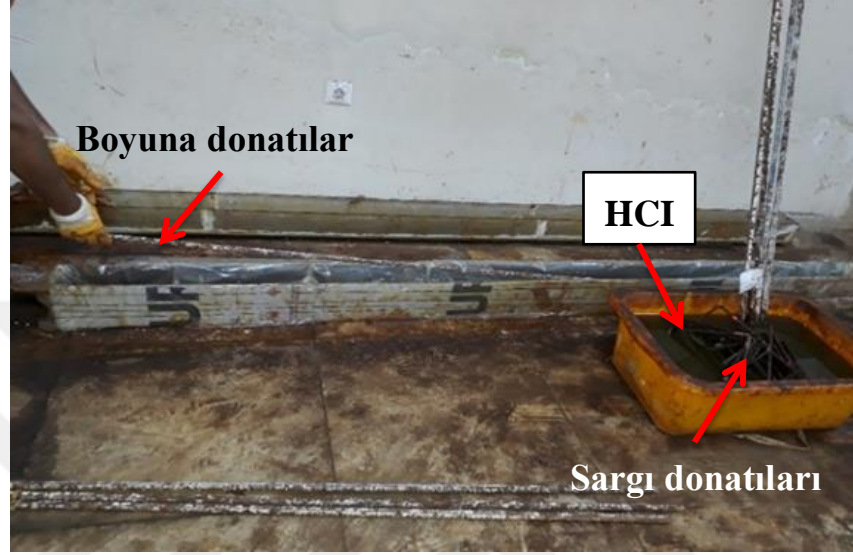
Şekil 5.2. Betonarme kolon boyuna ve sargı donatıları için kimyasal temizleme işleri.
