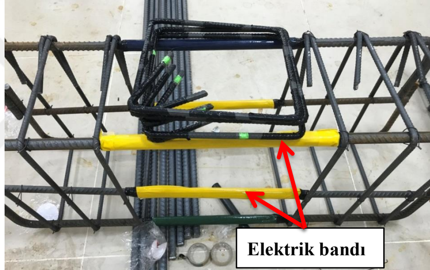
Şekil 4.15. Donatılara yerleştirilen plastik boruların elektrik bandı ile bantlanması.
