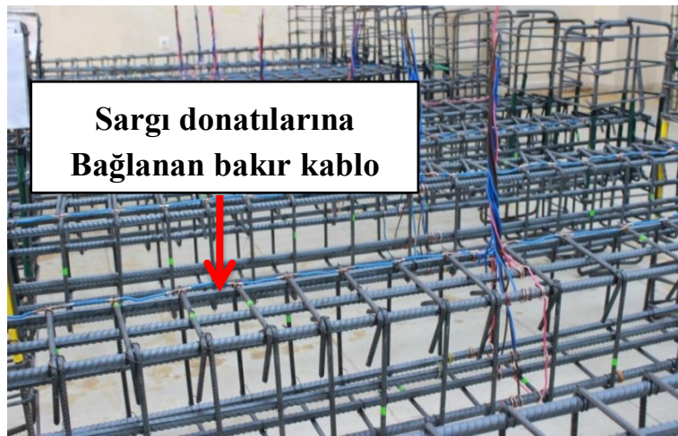
Şekil 4.22. Betonarme kolon sargı donatılarına bakır kabloların bağlanması.
