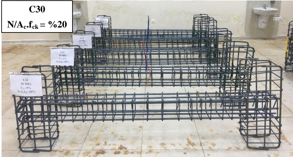
Şekil 4.23. Montajı tamamlanmış betonarme kolon numunelerinin donatı kafesleri.
