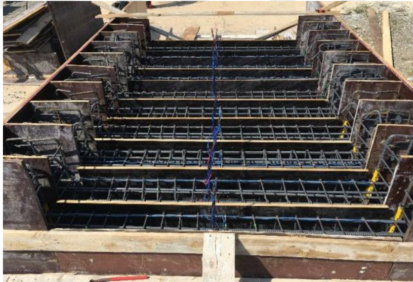
Şekil 4.25. Montajı tamamlanmış kalıplara donatı kafesinin yerleştirilmesi.
