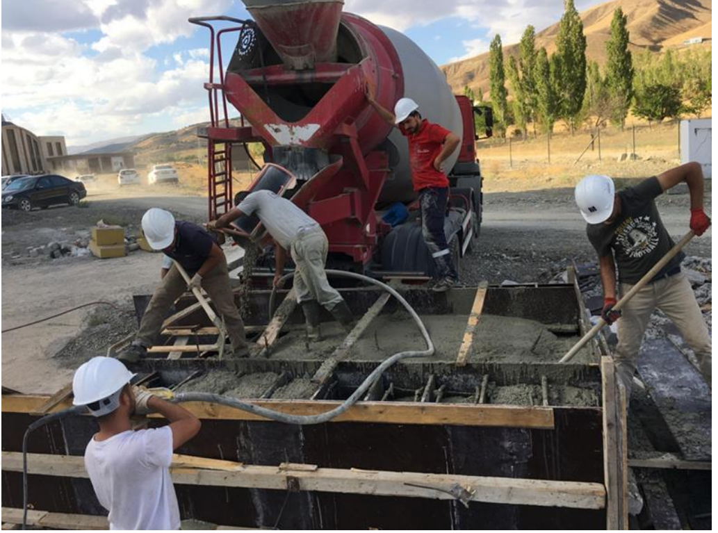
Şekil 4.26. Beton döküm işleri ve betonarme numunelere vibratör uygulanması.
