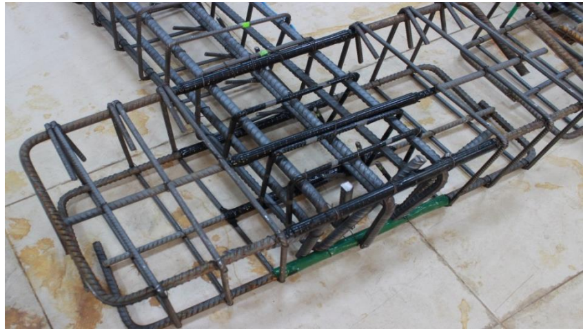
Şekil 4.16. Yalıtım işlemleri tamamlanmış betonarme donatılarının montajı.
