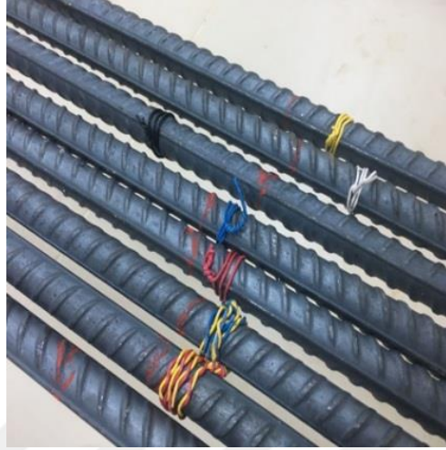
Şekil 4.13. Betonarme kolon boyuna donatılarına renkli kodlama kablolarının bağlanması.
