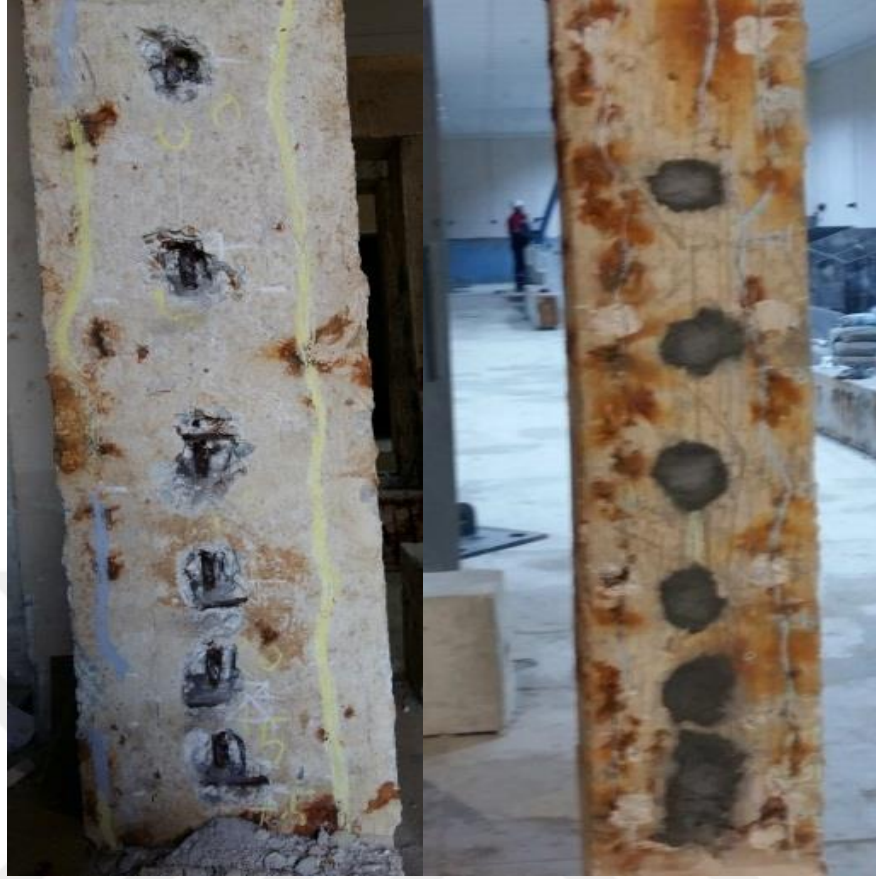
Şekil 4.45. Gerinim ölçerlerin yapıştırıldığı kısımlara tamir harcının uygulanması.
