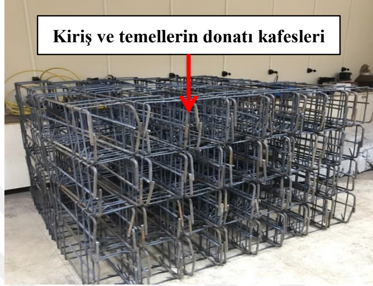
Şekil 4.19. Betonarme kiriş ve temel donatılarının bağlanması.
