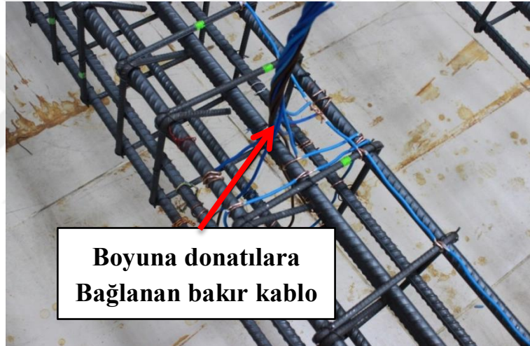
Şekil 4.21. Betonarme kolon boyuna donatılarına bakır kabloların bağlanması.
