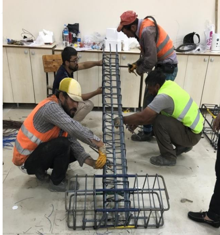
Şekil 4.20. Betonarme kolon boyuna ve sargı donatılarının bağlanması.
