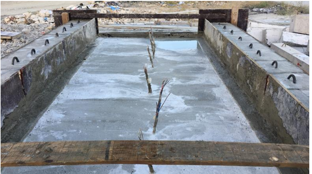
Şekil 4.27. Beton döküm işlemi tamamlanmış kolon numuneler.
