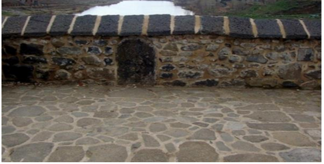
Şekil 4.8. Köprü Üzerinde Bulunan Namazgah.
