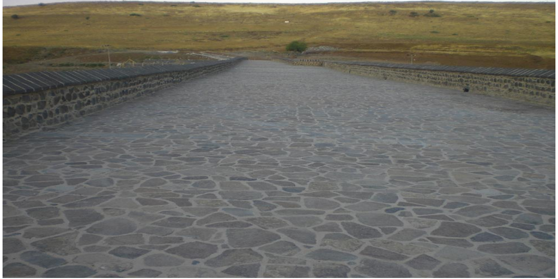
Şekil 4.9. Dicle (On Gözlü) Köprüsü Yol Kaplaması.
