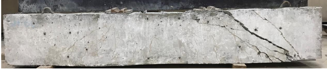
Şekil 4.5. SH-G45 numunesinin çatlak gelişimi
