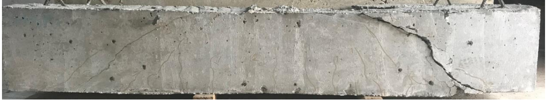
Şekil 4.11. SH-S90 numunesinin çatlak gelişimi
