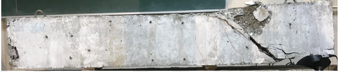
Şekil 4.7. SH-G60 numunesinin çatlak gelişimi
