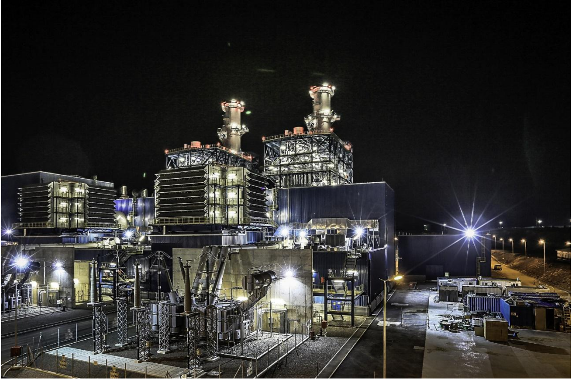
Şekil 5.6. Yeni Elektrik Doğal Gaz Kombine Çevrim Santrali (Yeni Elektrik Üretim A.Ş., 2019).
