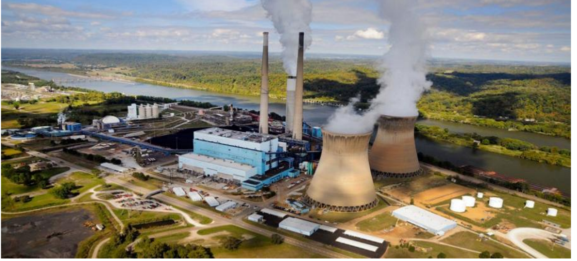
Şekil 4.1. Termik Santral (Küçükkaya, 2019).
