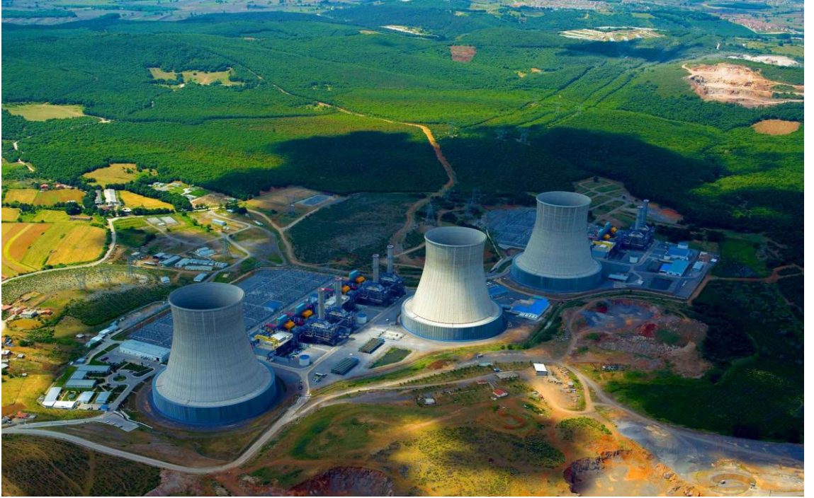
Şekil 5.1. Enka Gebze Doğal Gaz Kombine Çevrim Santrali (Enka POWER, 2019).
