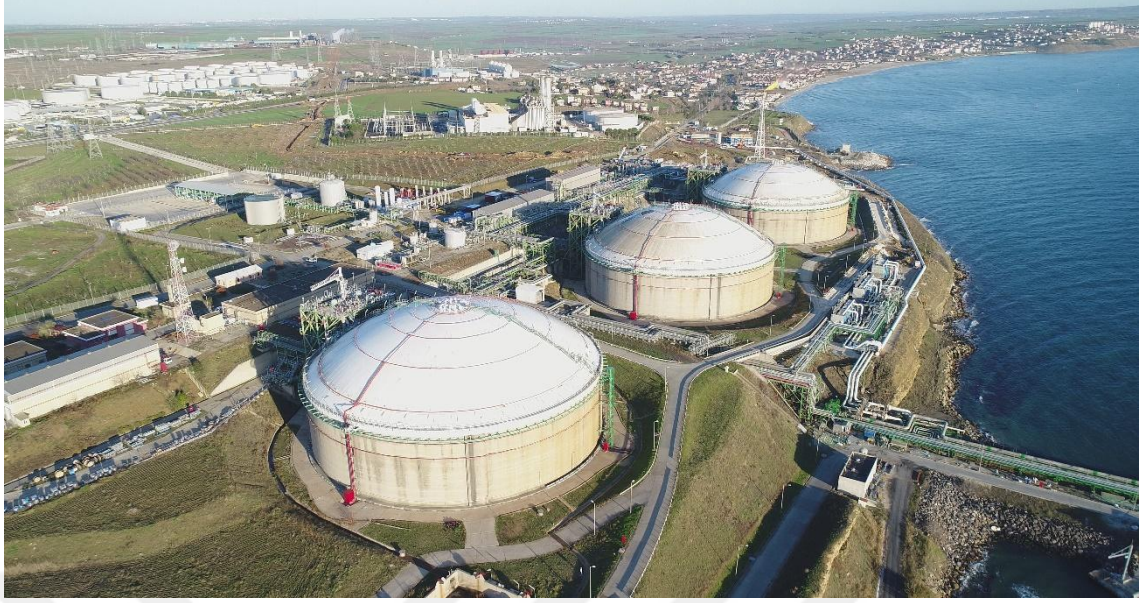
Şekil 3.10. Marmara Ereğlisi LNG Terminali (BOTAŞ, 2019).
