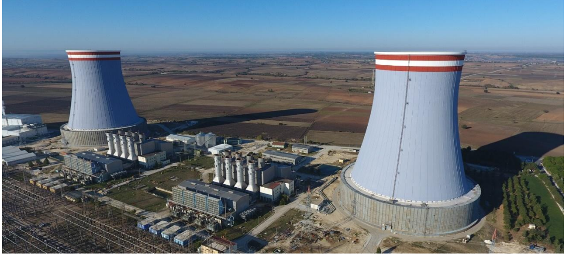
Şekil 5.4. Hamitabat Doğal Gaz Kombine Çevrim Santrali (Limak ENERJİ, 2019).
