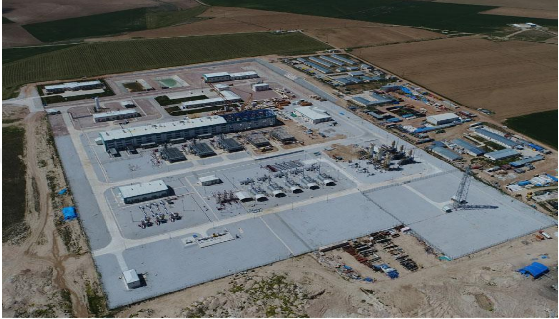
Şekil 3.11. Tuz Gölü Yeraltı Doğal Gaz Depolama Tesisi (BOTAŞ, 2019).
